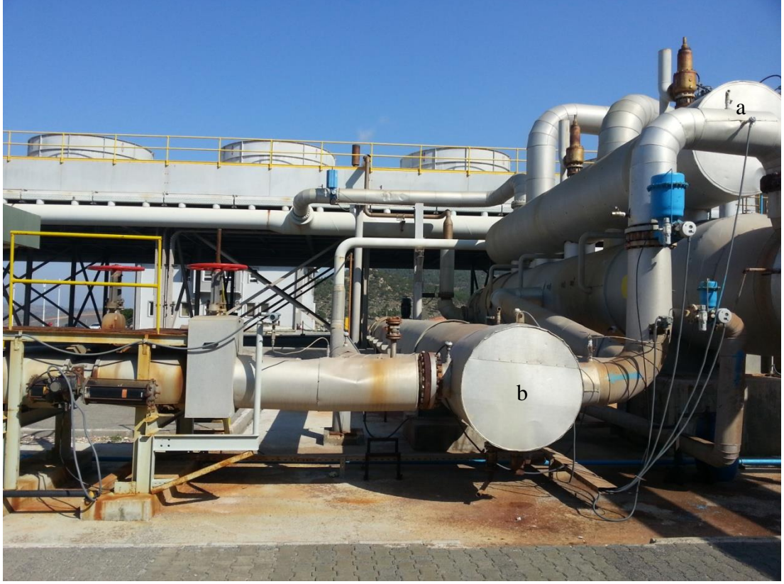
Şekil 5.2. Sistemde kullanılan a) buharlařtırıcı b) ön ısıtıcı.
