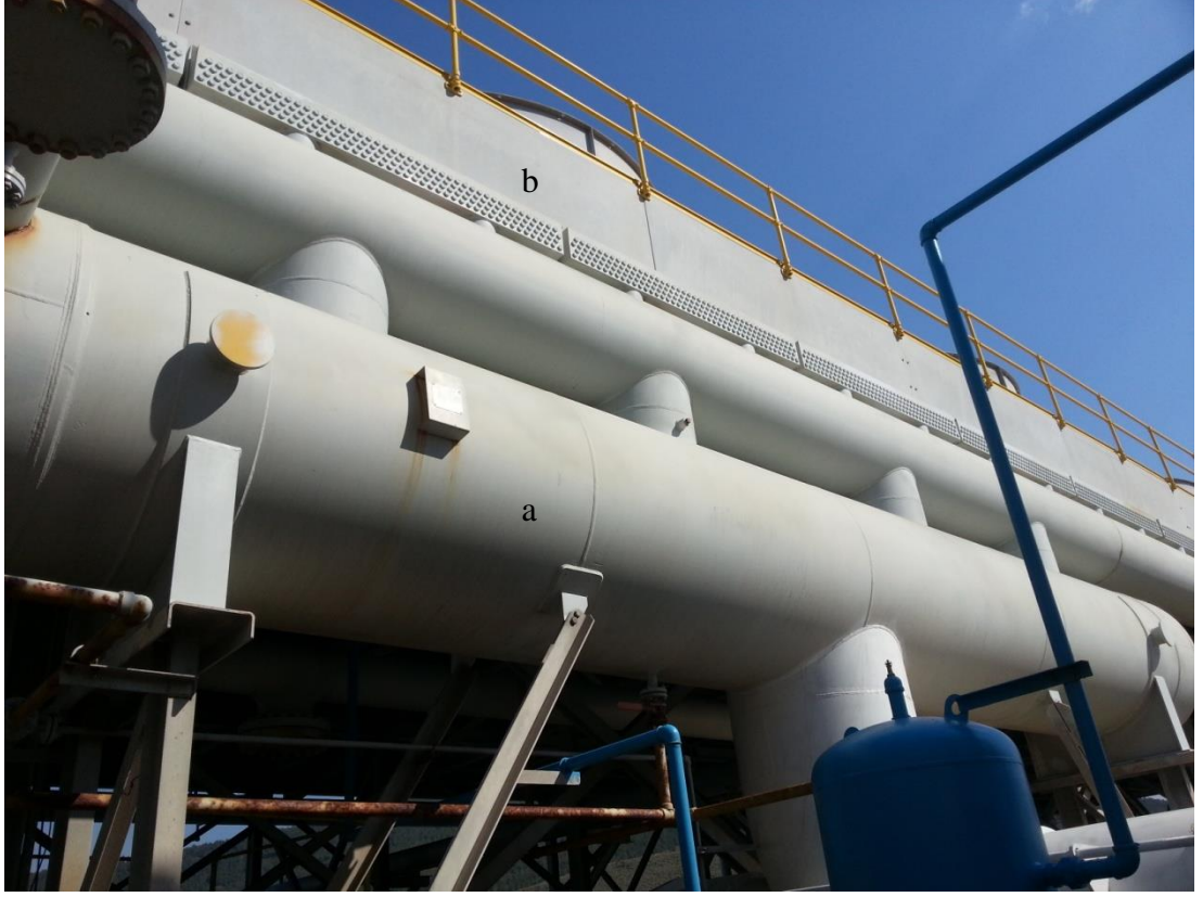
Şekil 5.4. Sistemde kullanılan a) reküperatör b) hava soğutmalı kondenser.
