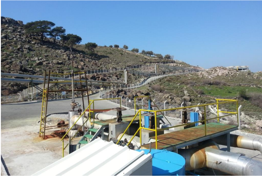
Şekil 5.1. Jeotermal akışkanın sisteme taşınması.
