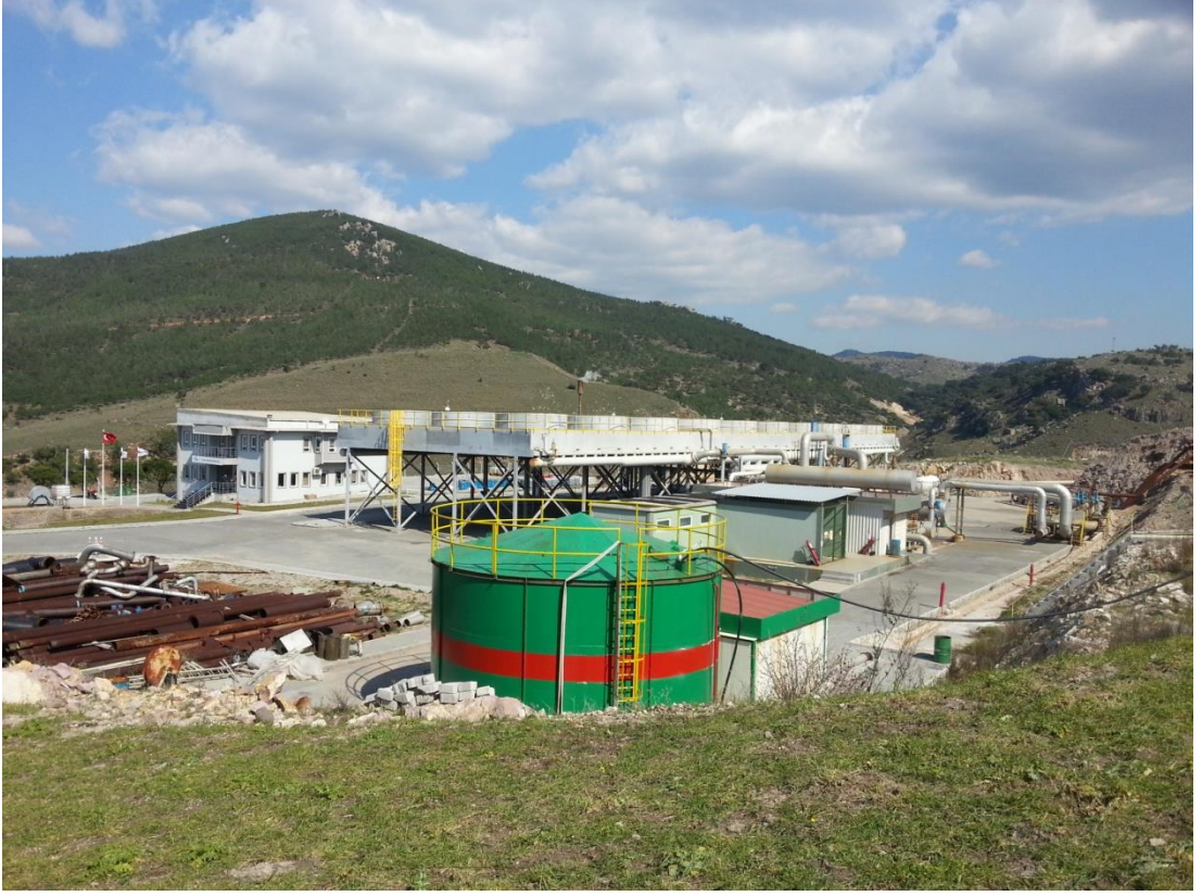
Şekil 5.6. Tesisin genel görünümü.
