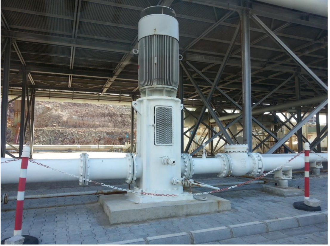
Şekil 5.5. Sistemde kullanılan organik akışkan pompaları.
