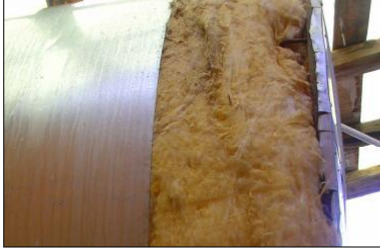
Şekil 4.3. Tank izolasyonu.
