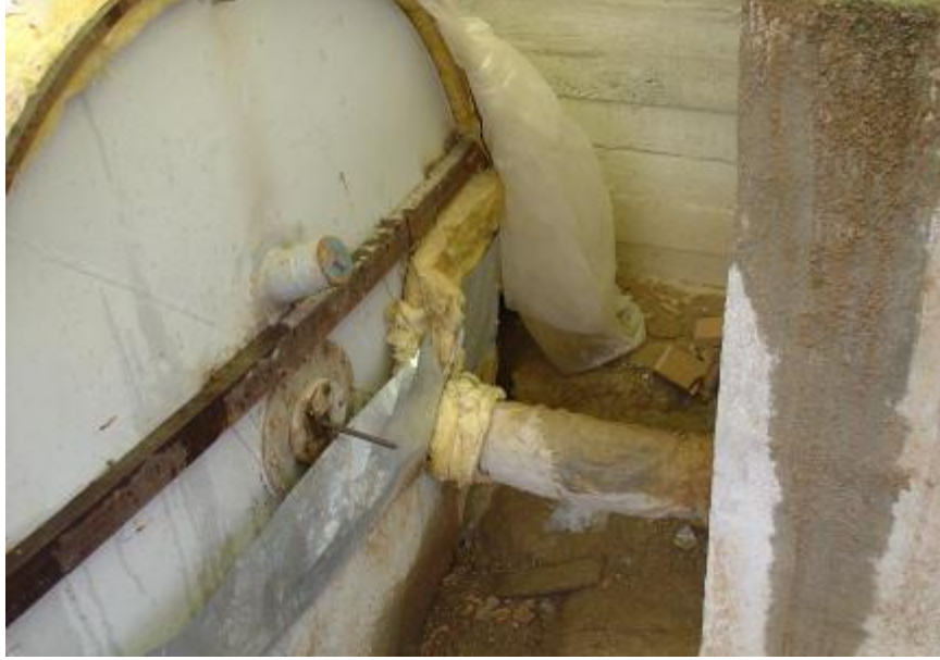
Şekil 4.7. Fermantasyon giriş ve çıkış borusu.
