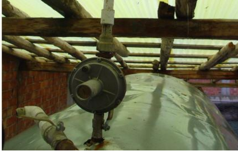
Şekil 4.6. Basınç emniyet supabı.
