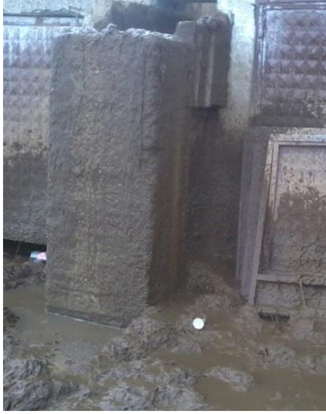
Şekil 4.8. Son gübre boşaltma havuzu.
