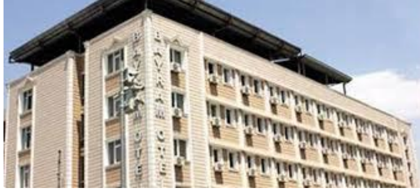
Őekil 2.21. 2011 Van depreminde yıkılan Bayram otelinin dıř cephe kaplamalarından bir g6r6n6m.
