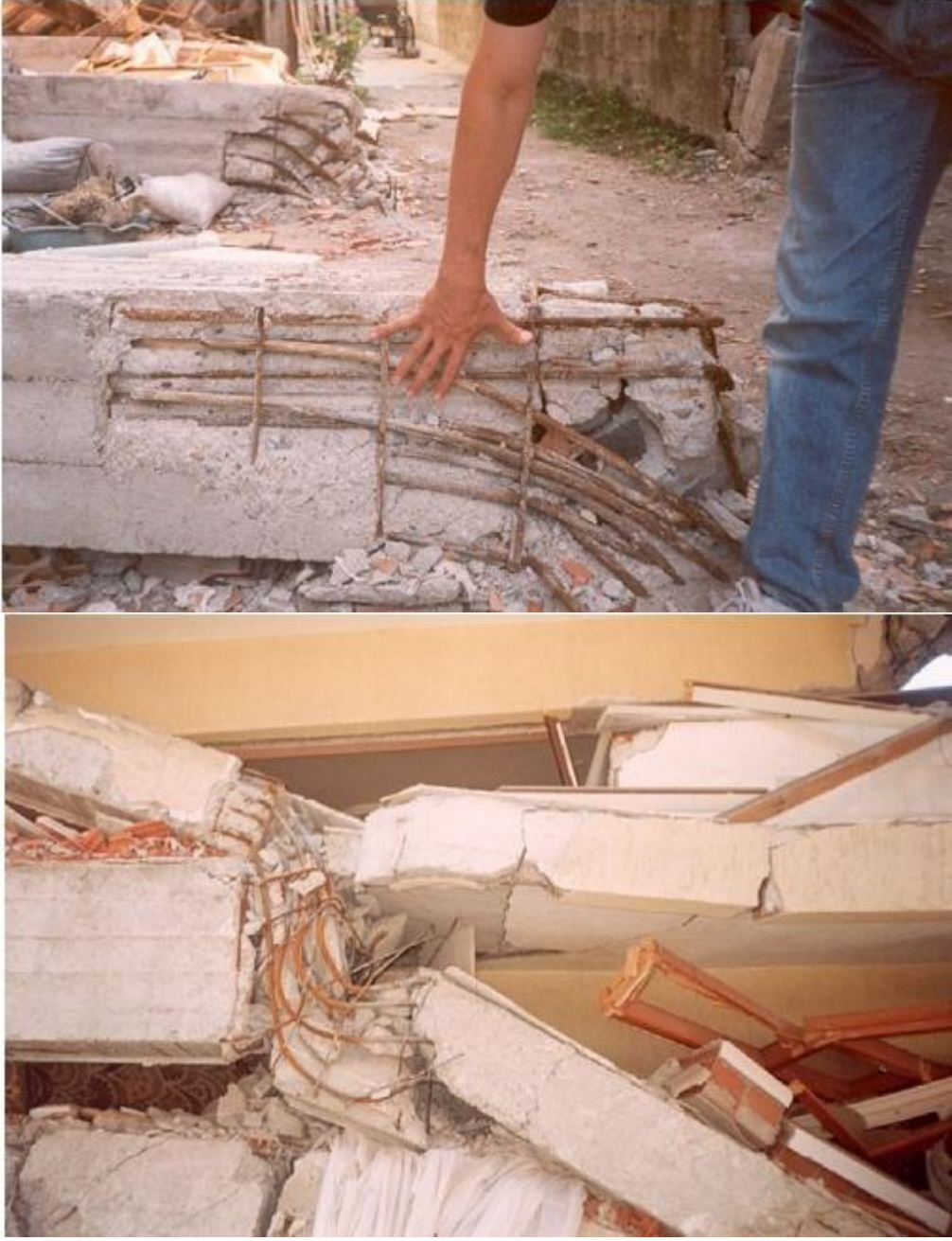
Şekil 2.13. Etriye sıklaştırmasının yetersizliğinden görünümler (Kutaniş vd., 2002).
