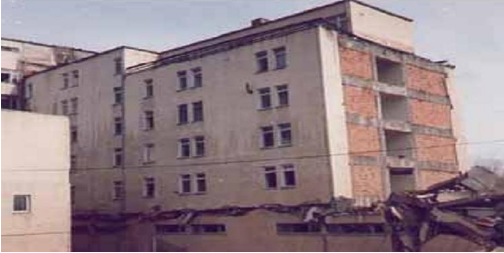
Şekil 3.1. Katlar arası dayanım farkından (zayıf kattan) oluşan yapısal hasardan bir görünüm (Özer, 2009).
