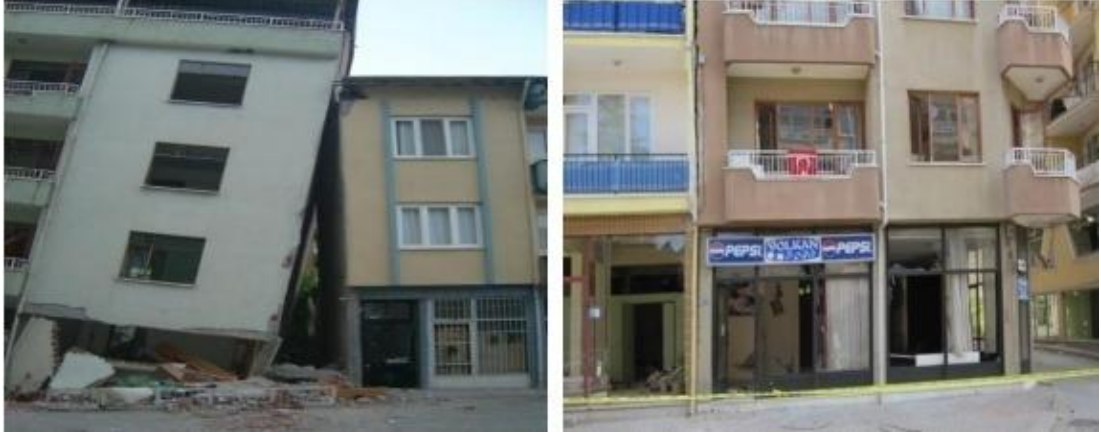
Şekil 3.6. Farklı binalarda yumuşak kat düzensizliği nedeniyle oluşan yapısal hasarlardan görünüm (Yön et al., 2013).
