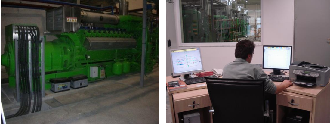
Şekil 10.15. Motor, jeneratör grubu ve otomasyon.
