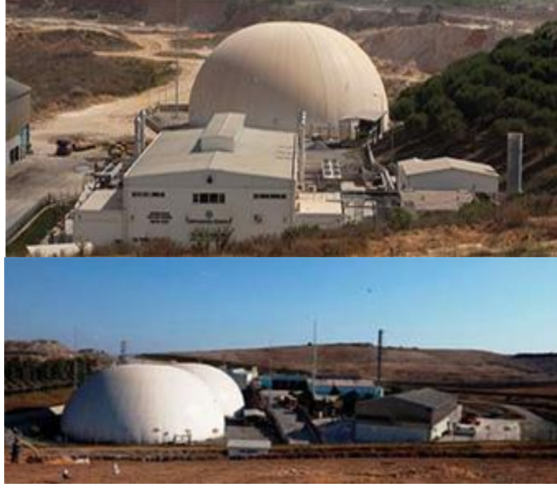
Şekil 10.16. Membran gaz depolama balonları.
