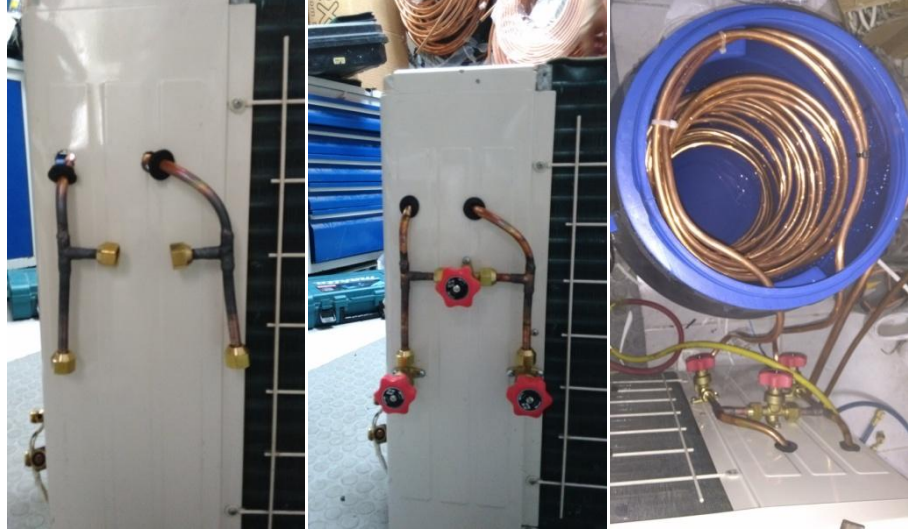
Şekil 4.12. Dış ünite vana ve boyler bağlantıları.
