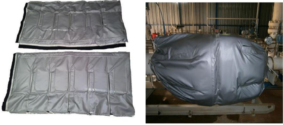
Şekil 4.6. Regülatörler için ısıtıcı ve ısı ceket uygulaması.
