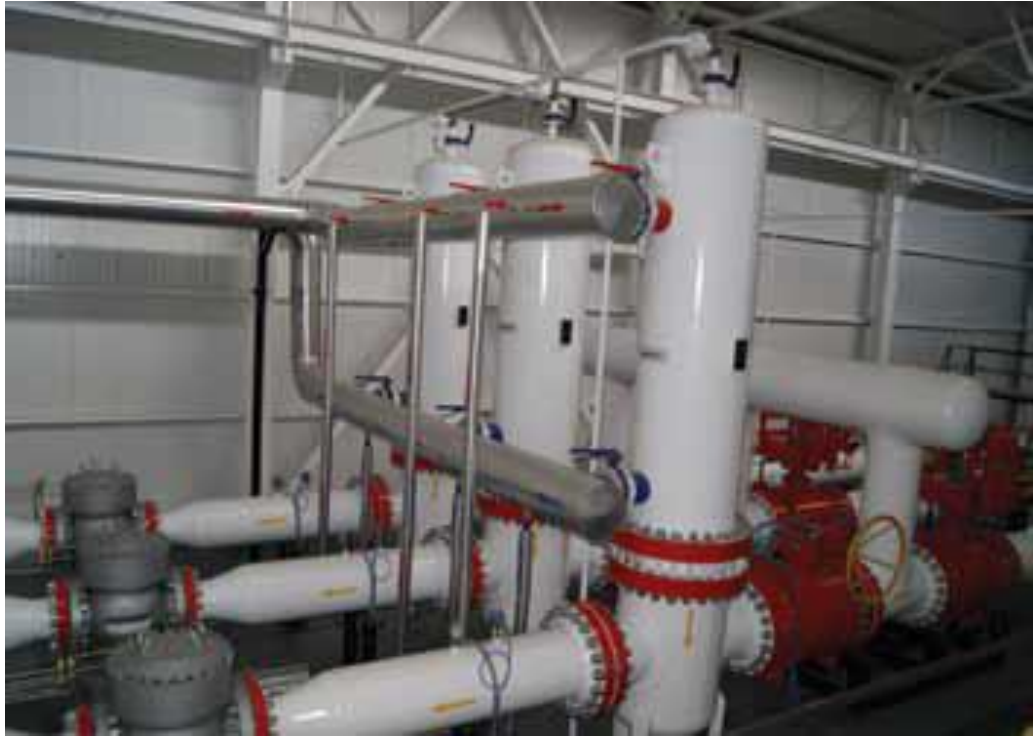
Şekil 3.6. Isıtma ve regülasyon grubu.
