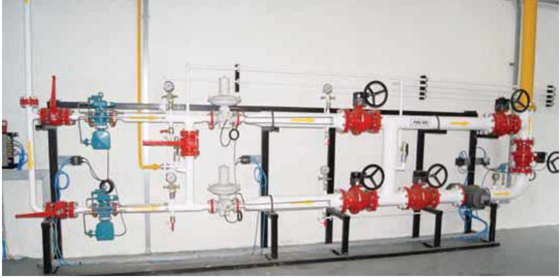
Şekil 3.5. Kazan dairesi ısıtma gazı besleme grubu.
