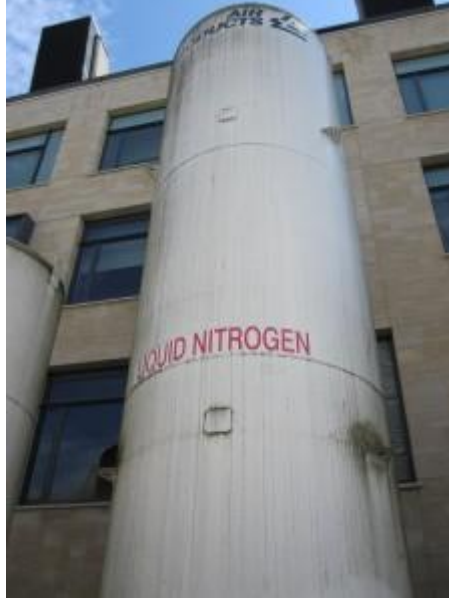
Şekil 3.1. Sıvı azot üretim ünitesi.
