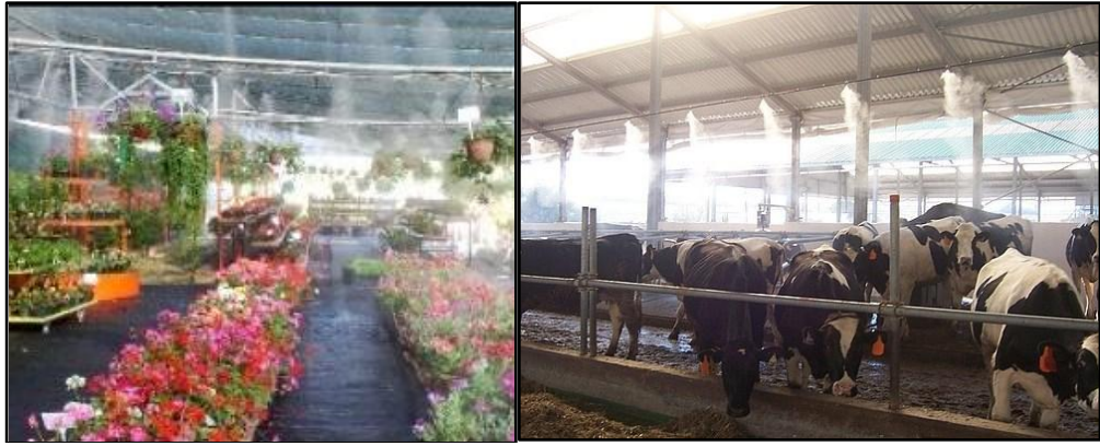
Şekil 2. 5. Evaporatif soğutma kullanım alanları.
