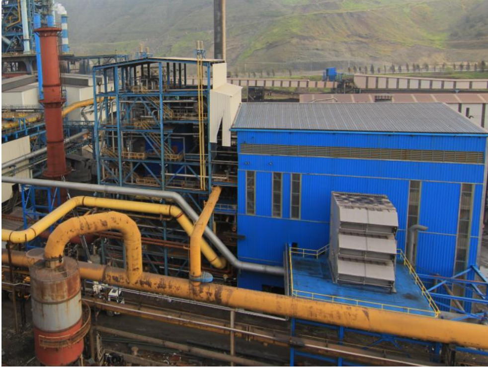
Şekil 3.1. Tesisin genel görünüşü.
