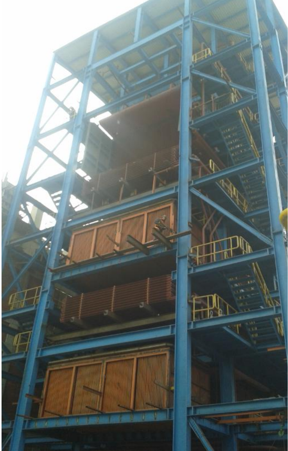
Şekil 3.10.Ekonomizer ve hava ekonomizerlerinin genel yerleşimi.
