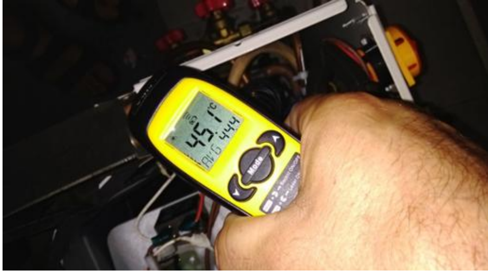
Şekil 6.5. Dış ünite kondenser sıcaklığı.
