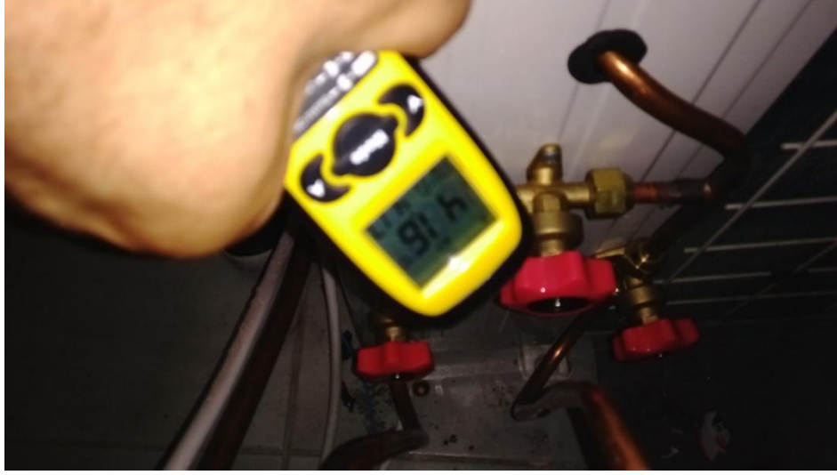
Şekil 6.1. Dış ünite boyler soğutucu akışkan giriş-çıkış sıcaklıkları.
