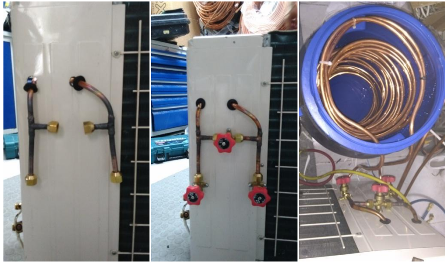
Şekil 5.12. Dış ünite, vana ve boyler bağlantıları.
