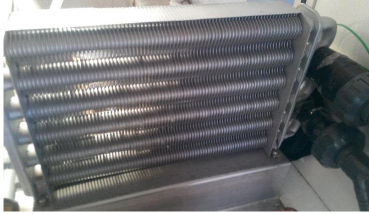
Şekil 7.5. Evaporatör.
