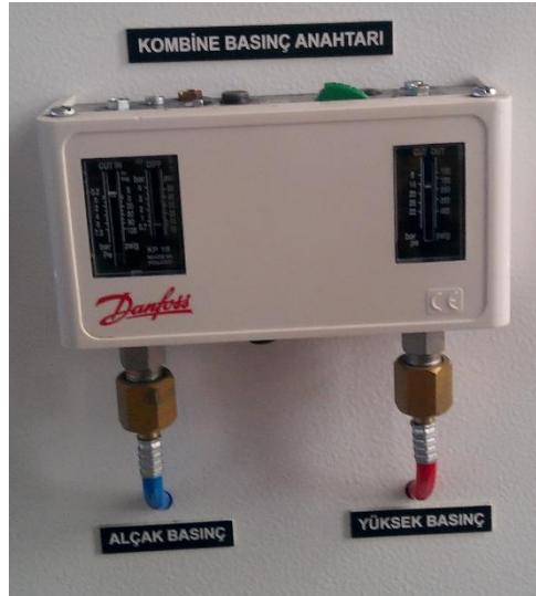
Şekil 7.6. Kombine basınç anahtarı.
