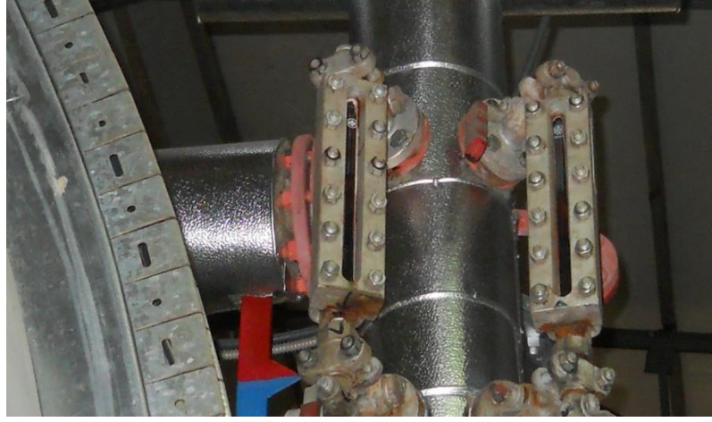
Şekil 5.8. Tekstil işletmesindeki mevcut yüzey blöf.
