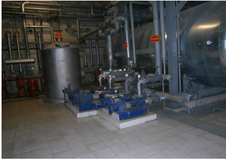
Şekil 5.11. Tekstil işletmesindeki mevcut elektrik motorlarının bağlantı sistemleri.
