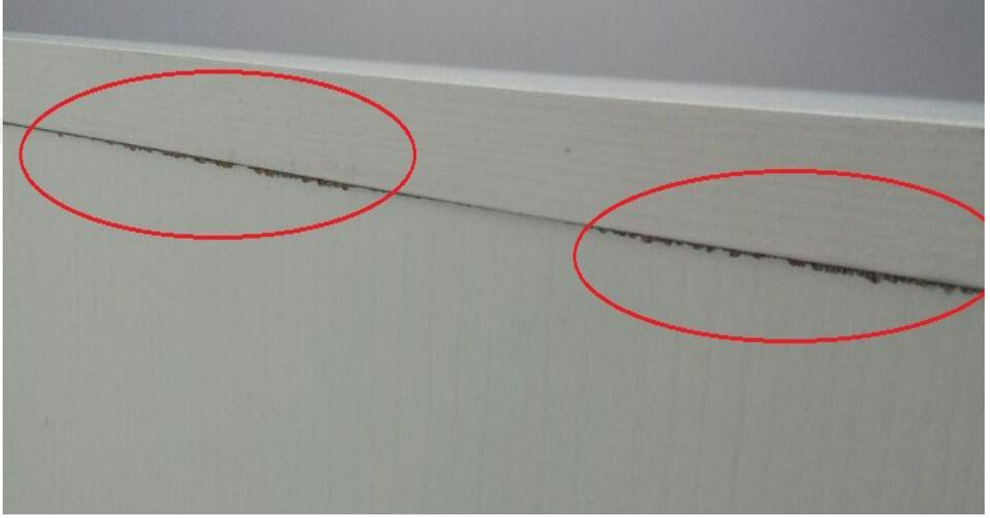
a) Görünür yüzeyde kalan testere kırığı.
