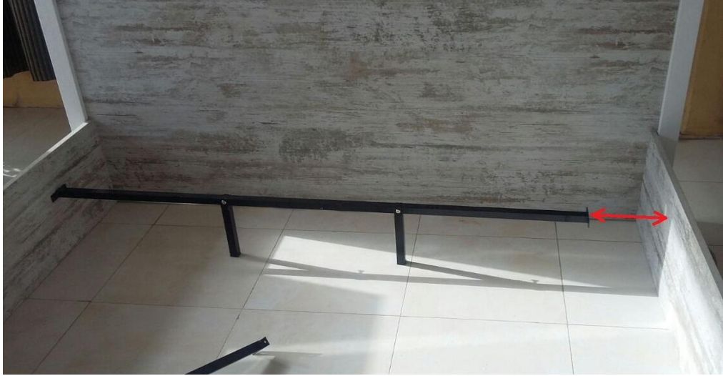
b) Pakete olması gerekenden kısa mannesman profil konulması.
