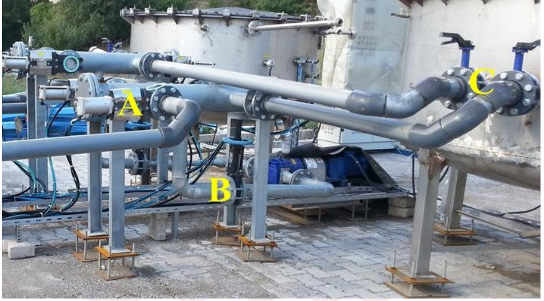
A)Pnömatik Aktüatörlü Bıçaklı Vana B) Bıçaklı sürgülü vana C)Wafer tip kelebek vana
