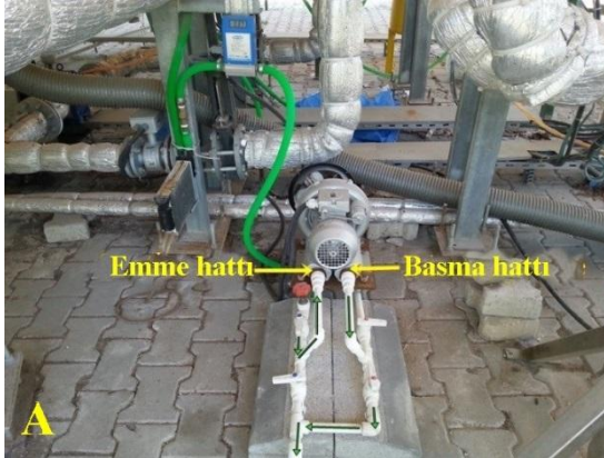
A) Blower yardımı ile fermentörden depoya biyogaz gönderimi
