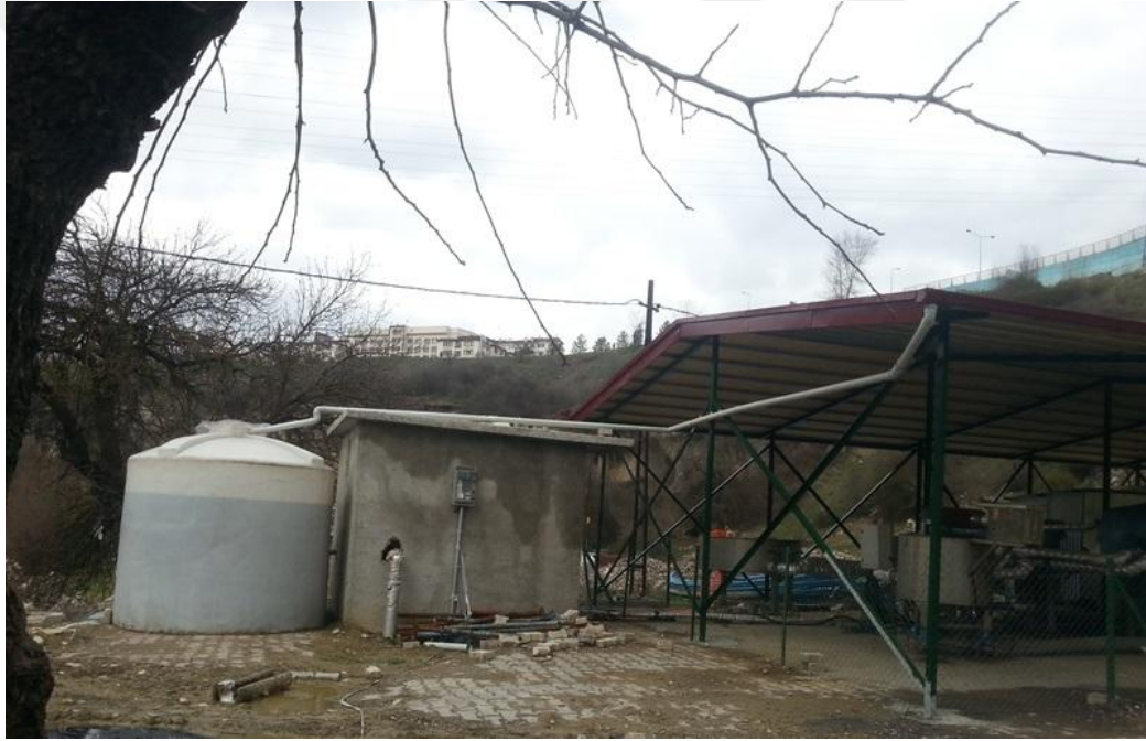
Şekil 5.10. Yağmur suyu toplama sistemi.
