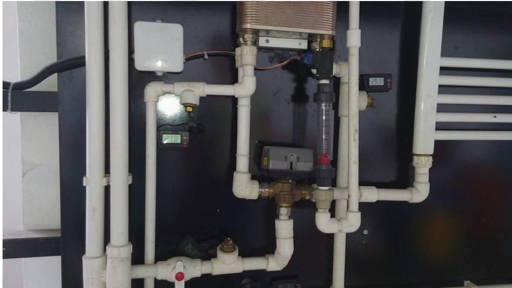
Şekil 3.1. Kapı önü sıcak su ünitesi.
