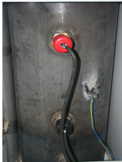
Şekil 3.7. Silindirik su ısıtıcısı.
