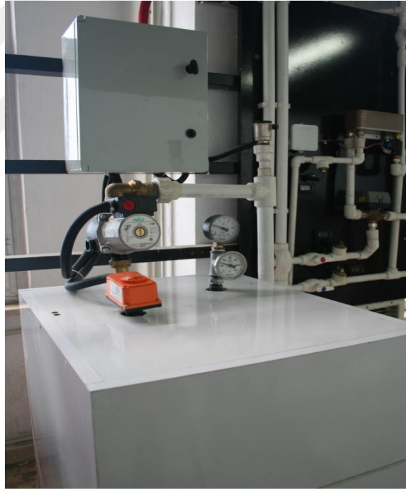
Şekil 3.9. Kapı önü eşanjörlü sıcak su hazırlama sisteminin sıcak su hazırlama elamanları.
