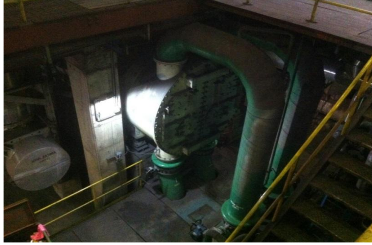
Şekil 3.6. 1 No'lu Shaangu turbo körük kondenseri.
