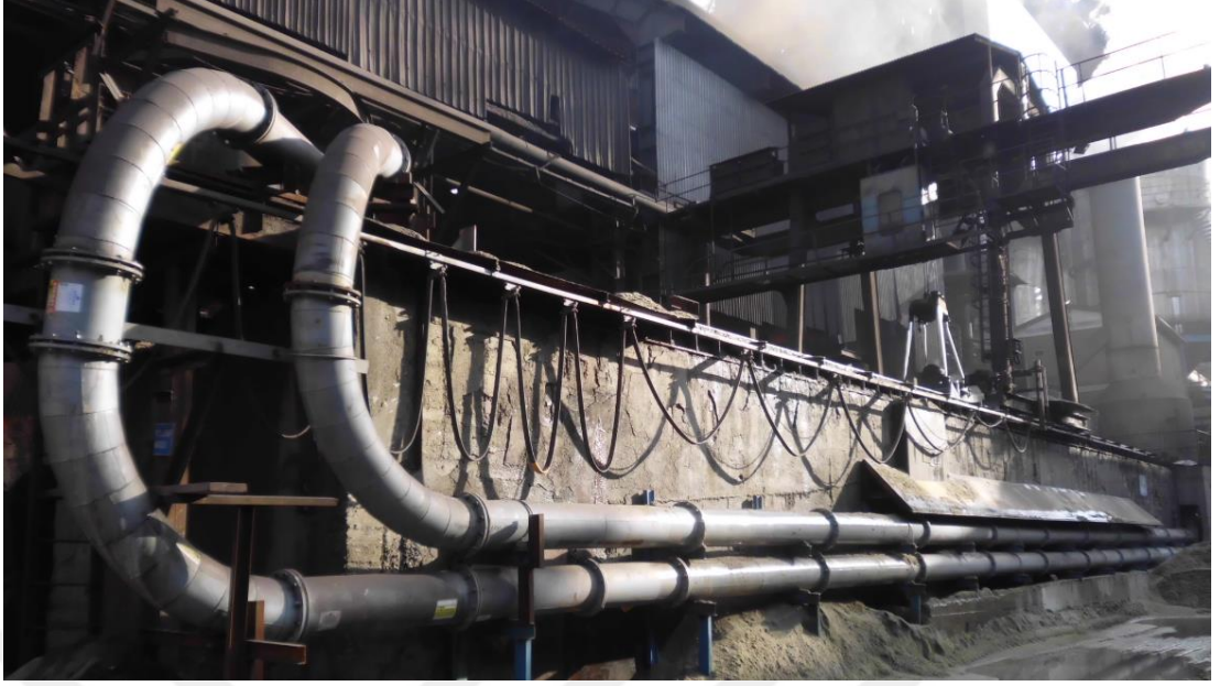
Şekil 6.4. Granüle edilmiş yüksek fırın cürufunun cüruf havuzuna basılmasında kullanılan borulara ait bir görüntü.
