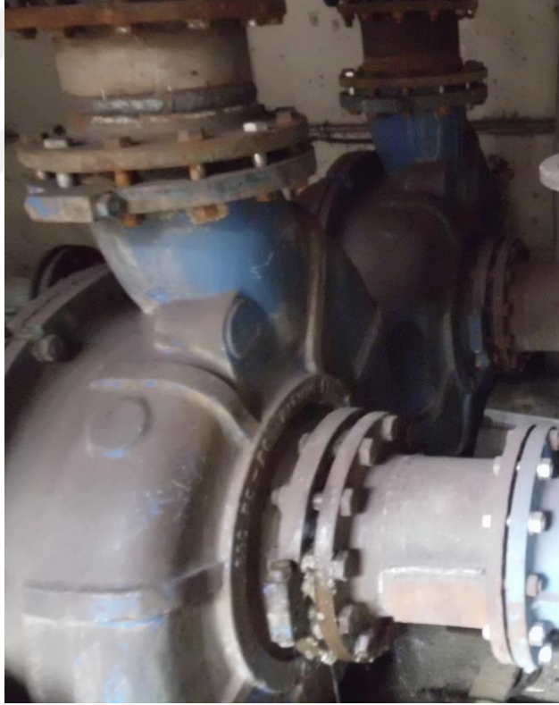
Şekil 6.3. Granüle edilmiş yüksek fırın cürufunun cüruf havuzuna basılmasında kullanılan pompalara ait bir görüntü.
