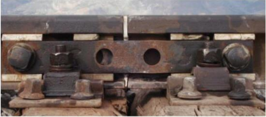
Şekil 3.12. Cebire ile bağlanmış raylar [28].
