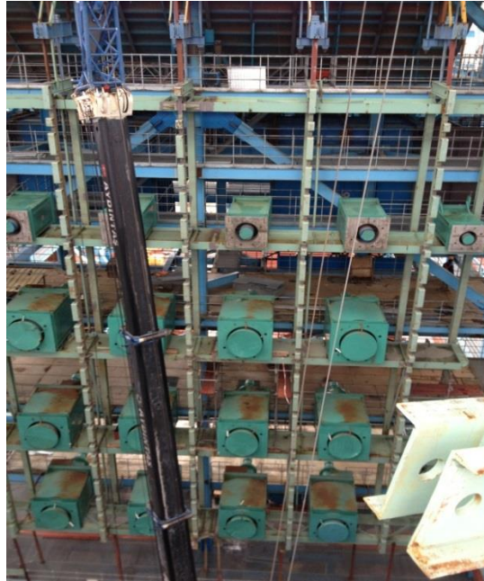
Şekil 4.2. Kazan yakıt yakıcıları.
