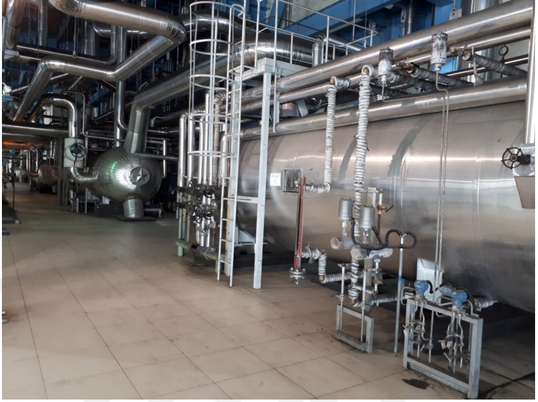
Şekil 4.12. Yüksek basınçlı (HP) ısıtıcılar.
