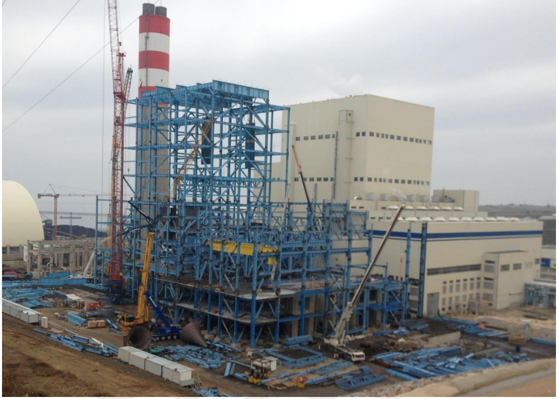
Şekil 4.1. Kazan - türbin binası genel görünüşü.
