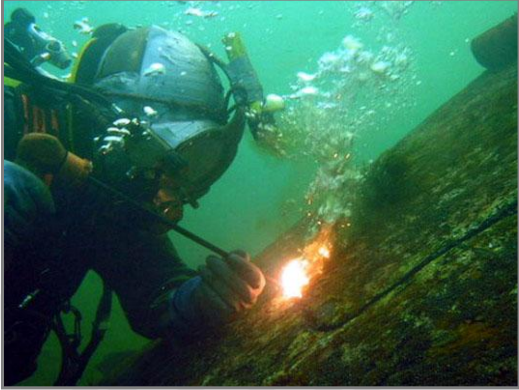
Şekil 4.2. Tamamen ıslak ortamda gerçekleştirilen su altı kaynağı uygulaması.
