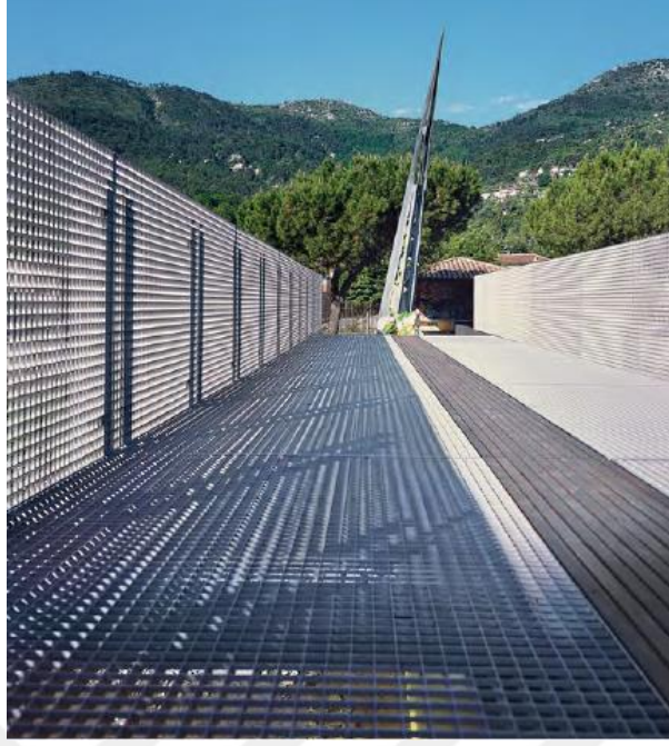
Şekil 2.15. Paslanmaz çelik ızgaradan yapılmış yaya köprüsü, Contes Fransa [30].
