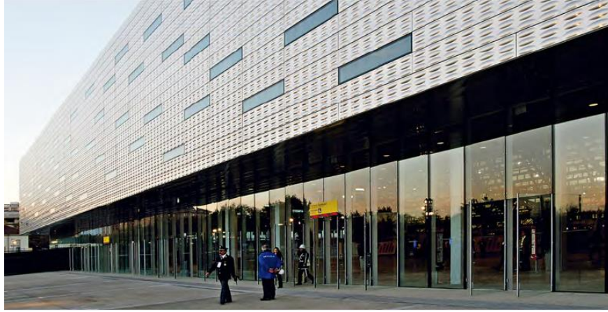
Şekil 2.16. Buz hokeyi stadyumu dış cepe giydirmesi 1.2 mm paslanmaz çelik paneller, Turin İtalya [30].
