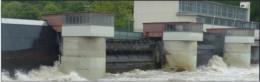
Şekil 2.13. Paslanmaz çelikten üretilen baraj kapakları [28].
