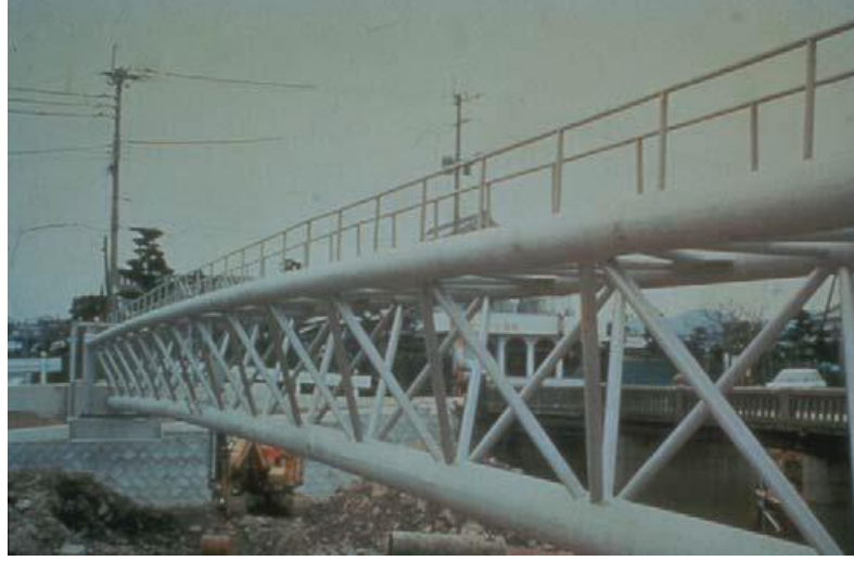
Şekil 2.14. Paslanmaz malzemedan üretilen içme suyu taşıma köprüsü, Tokyo Japonya [29].
