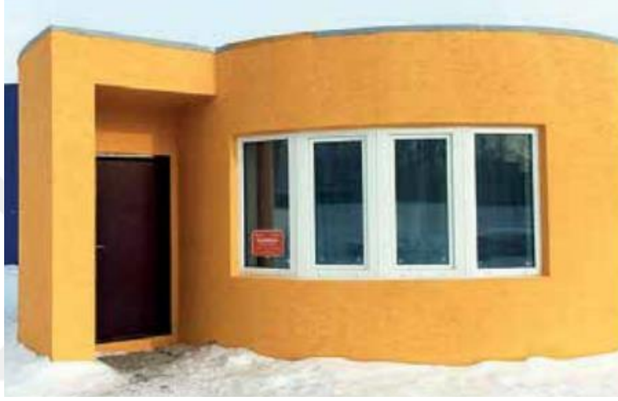
Şekil 4.11. İlk mobil üç boyutlu yazıcı ile 24 saatte 37 metrekare inşa edilen ev [38].
