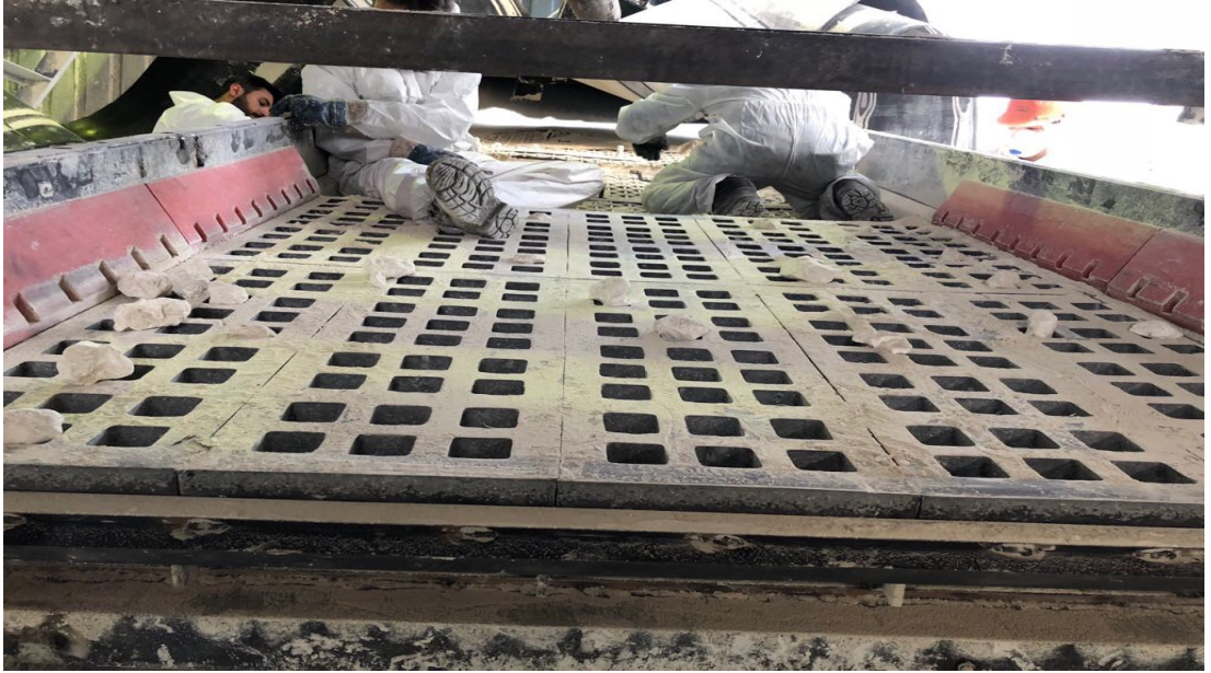
Şekil 6.9. Kauçuk esaslı elek panellerin montajının yapılması anı görüntüsü.
