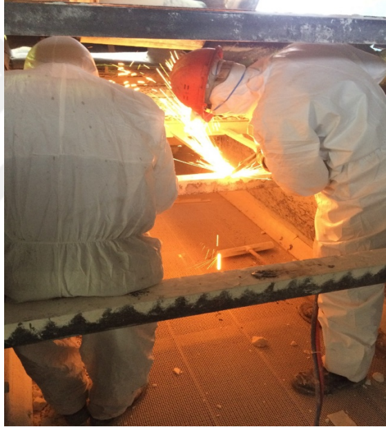
Şekil 6.7. Çelik esaslı elek panel şaselerinin kesilerek demontajı anı gösterimi.
