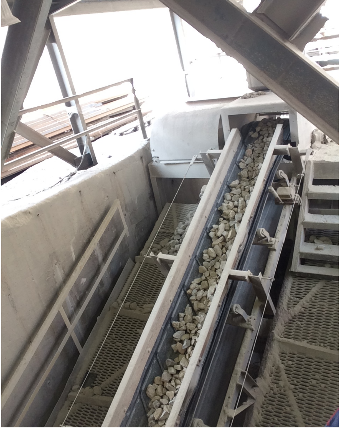
Şekil 3.4. Kireç taşlarının bantlı konveyörlerle tartım bunkerine transferi anı görünümü.
