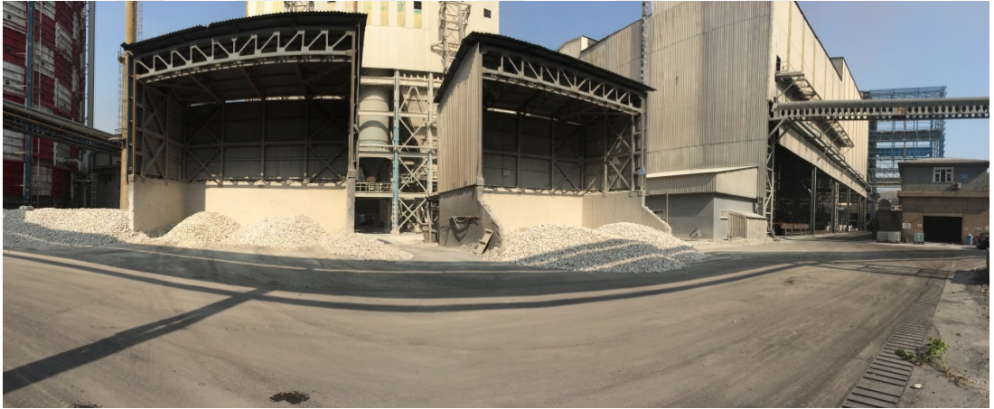
Şekil 3.1. Kardemir A.Ş. kireç fabrikasında bulunan kireç taşı yer altı bunkerleri genel görünümü.
