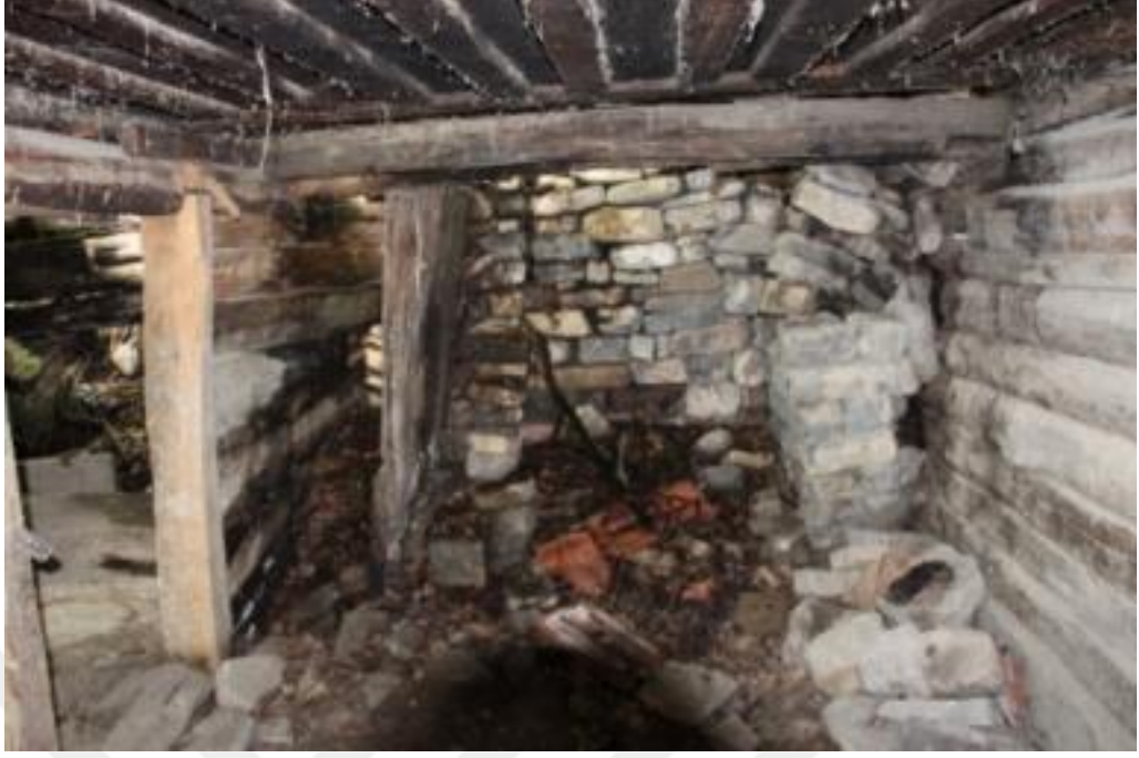
Şekil 4.11. Akkışla Köyü Değirmeni dinlenme ve konaklama bölümü.
