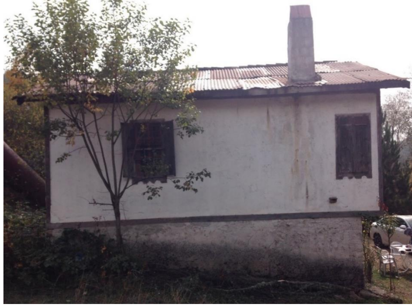
Şekil 4.19. Yukarıdana Köyü Hızar Değirmeni kuzey cephe görünüşü.
