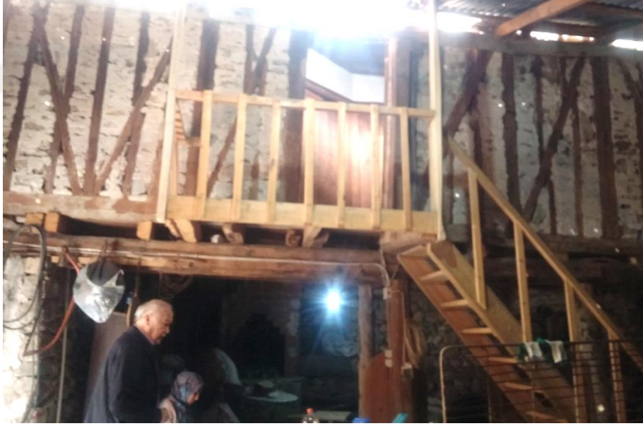
Şekil 4.25.Zemin ile 1. katı bağlayan ahşap merdiven.
