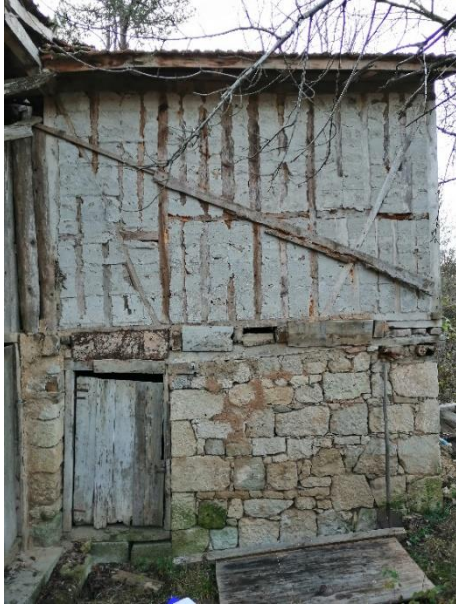
a) Değirmen ana odasından değirmenci evi ve ahırın doğu cephesi görünüşü.
