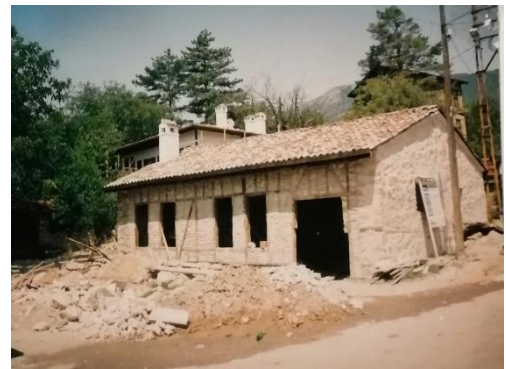
b) Bağlar Değirmeni restorasyon uygulaması güneydoğu görünüşü.
