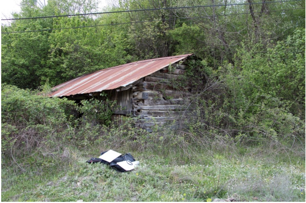
Şekil 3.32. Nahta Değirmeninin yoldan görünüşü (güneydoğu görünüşü).
