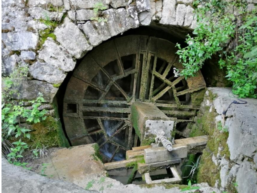
Şekil 3.17. Yazıköy Yağlının Değirmenine ait, günümüzde kullanılmayan, özgün yatay milli su çarkı.
