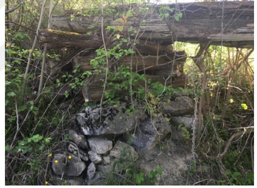
d) Yıpranmış özgün ahşap kanallar.
