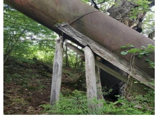
b) Demir boru sağ yan görünüş.
