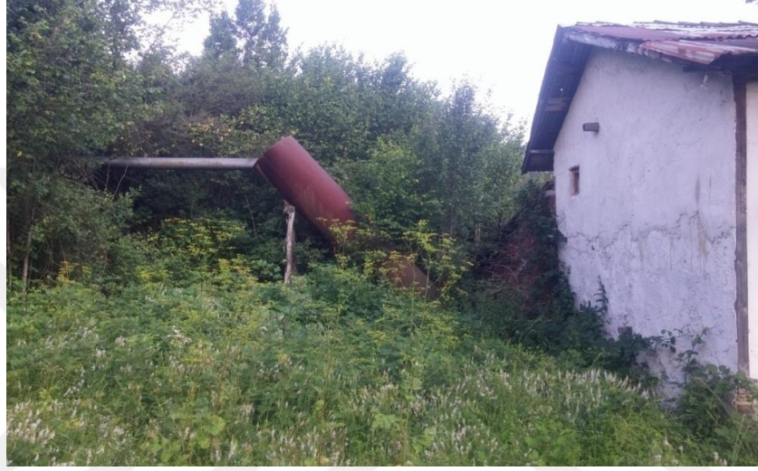
Şekil 4.18. Yukarıdana Köyü Hızar Değirmeni doğu cephe görünüşü.
