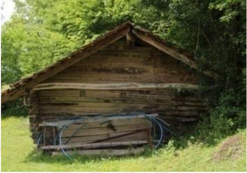
Şekil 4.3. Akkışla Köyü Değirmeni kuzeydoğu cephesi.
