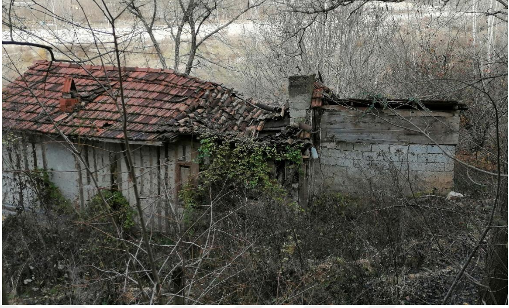
Şekil 4.39. Çıraklar Köyü Hacı Abdullah Değirmeni batı cephesi.
