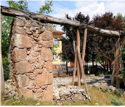
c) Değirmen özgün ahşap kanallar ve moloz taştan imal edilmiş ayaklar.
