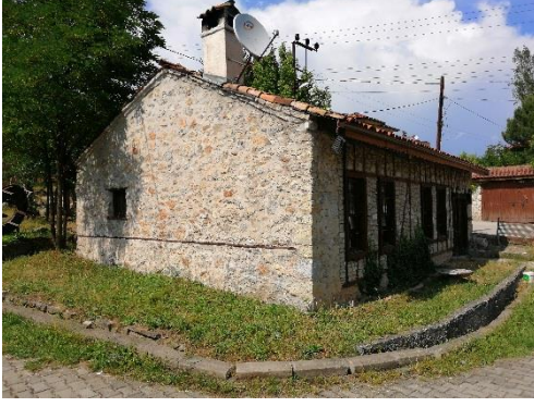
a) Değirmen güneybatı görünüşü.
