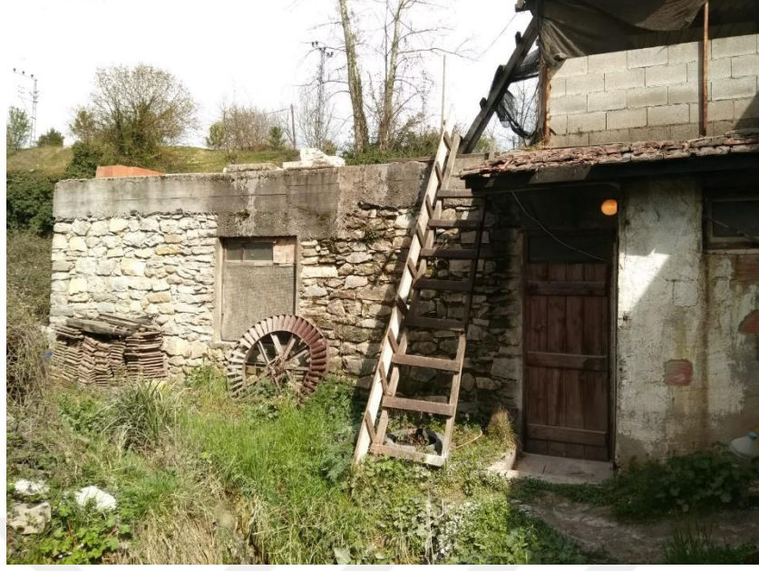
Şekil 3.28.Karıt Köyü Değirmeni arka cephe görünüşü.
