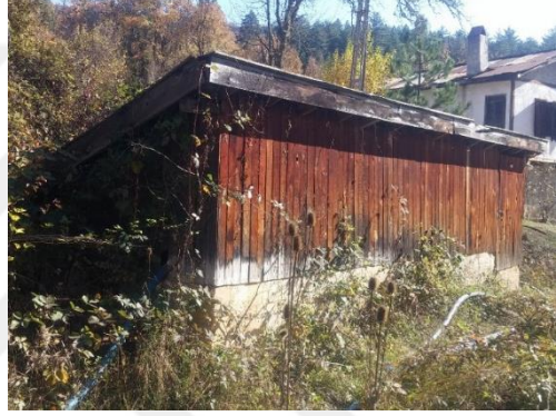
d) Değirmen yapısı çevresinde yer alan su deposu.
