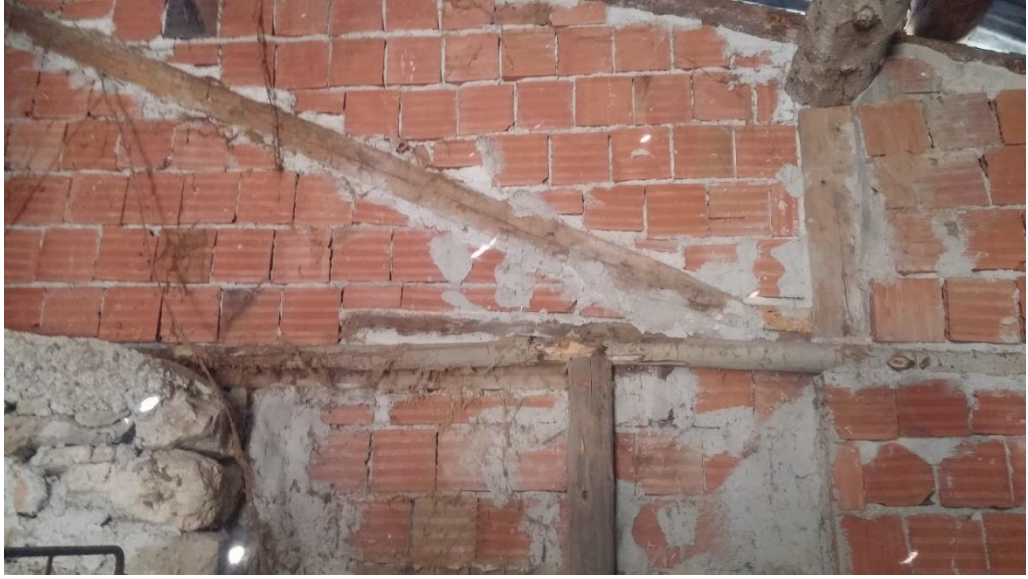
b) Özgün olmayan tuğla duvar imalatı.
