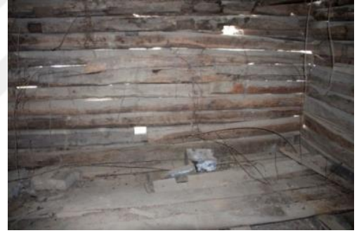
d) Çantı tekniği ile inşa edilen ahşap duvarlar.
