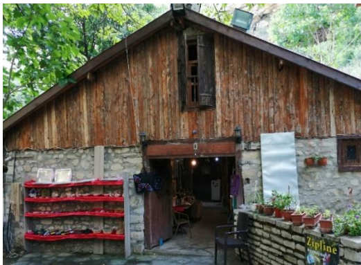
b) Değirmen sağ yan cephe.
