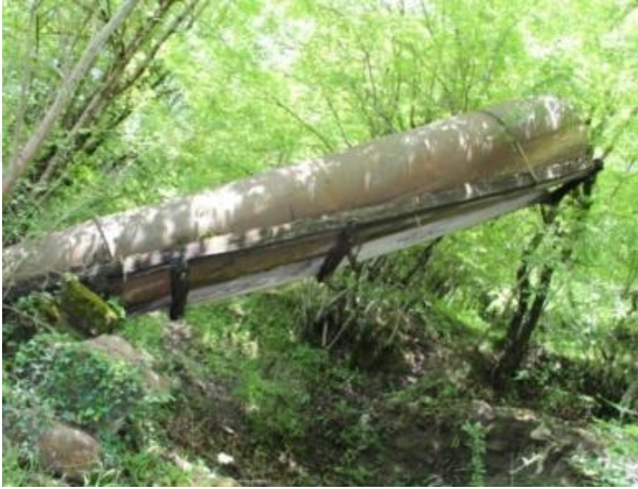
Şekil 4.6. Akkışla Köyü Değirmeni demir su borusu.
