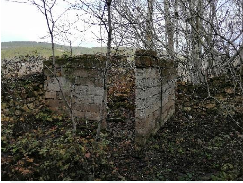
Şekil 4.45. Çıraklar Köyü Hacı Abdullah Değirmene inşa edilen eklenti oda.
