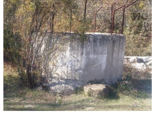
b) Değirmen yapısı çevresinde yer alan betonarme su deposu.
