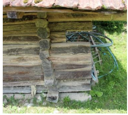
b) Değirmen çantı sistem duvar detayı
