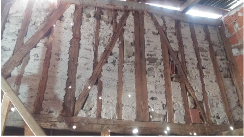
a) Ahşap karkas arası taş ve kerpiç dolgu özgün duvar malzemesi.
