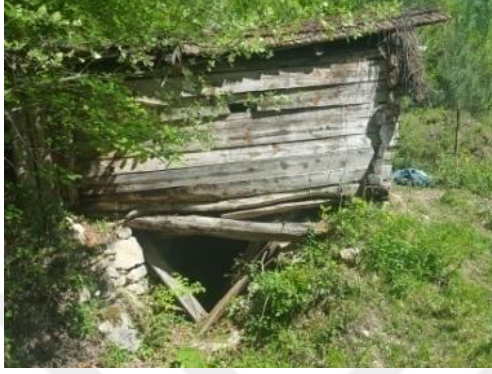
a) Cabbar Köyü Değirmeni batı cephesi.
