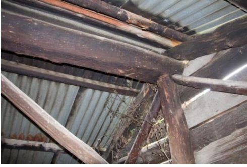
c) Değirmenin özgün olmayan çatı kaplaması
