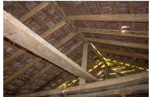
e) Özgün olamayan değirmen çatısının taşıyıcı sistemi.
