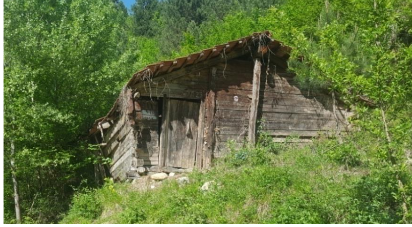
Şekil 3.43. Cabbar Köyü Değirmeni güney cephesi.
