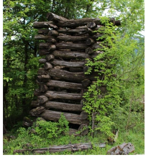
c) Değirmene su getiren ahşap olukları taşımak için imal edilmiş ayaklar.
