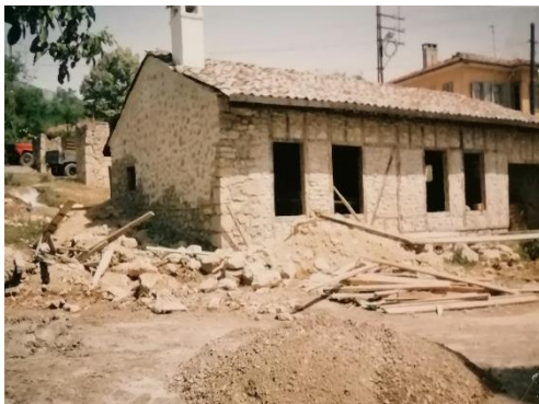
a) Bağlar Değirmeni restorasyon uygulaması güneybatı görünüşü.
