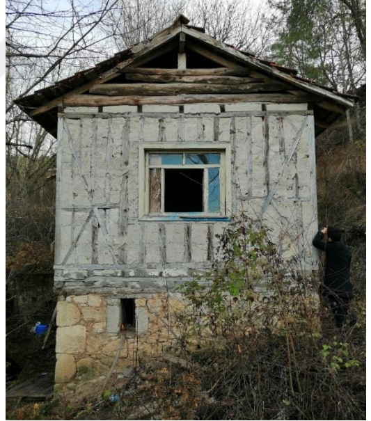
b) Değirmenci evi kuzey cephesi.
