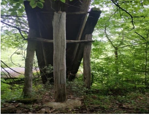
a) Demir boru ve taşıyıcı ahşap dikme.
