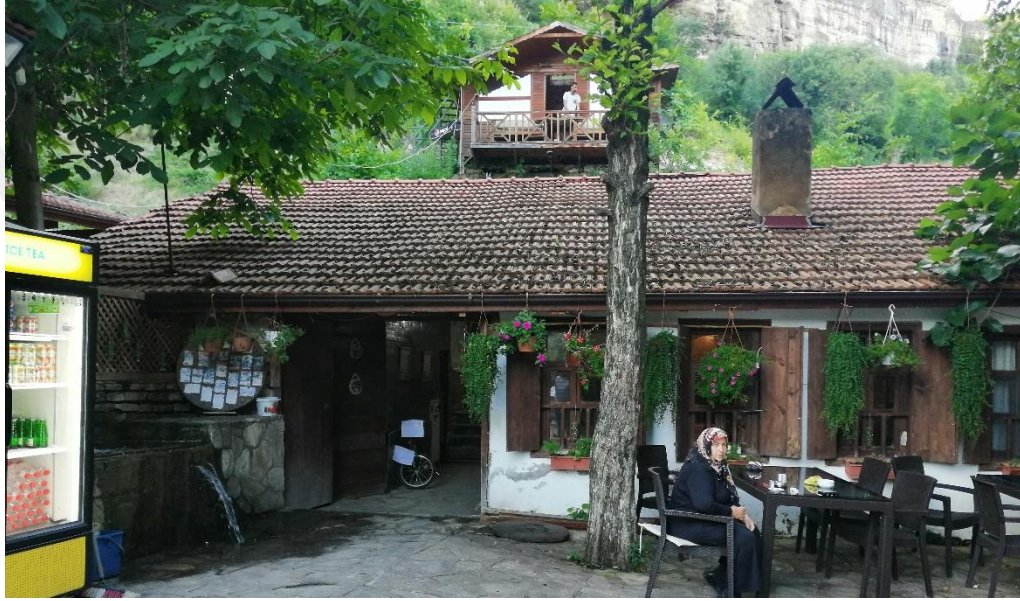
a) Yazıköy Yağlının Değirmeni ön cephesi.
