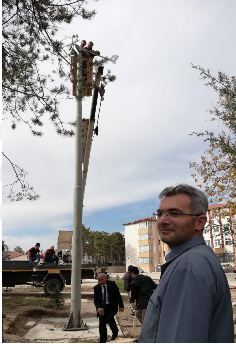
Şekil 5.3. Türbin direk montajı için yapılan çalışmalar.
