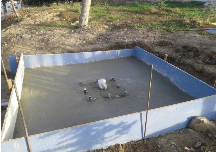
Şekil 5.2. Türbin direk montajı için yapılan beton döküm çalışması.
