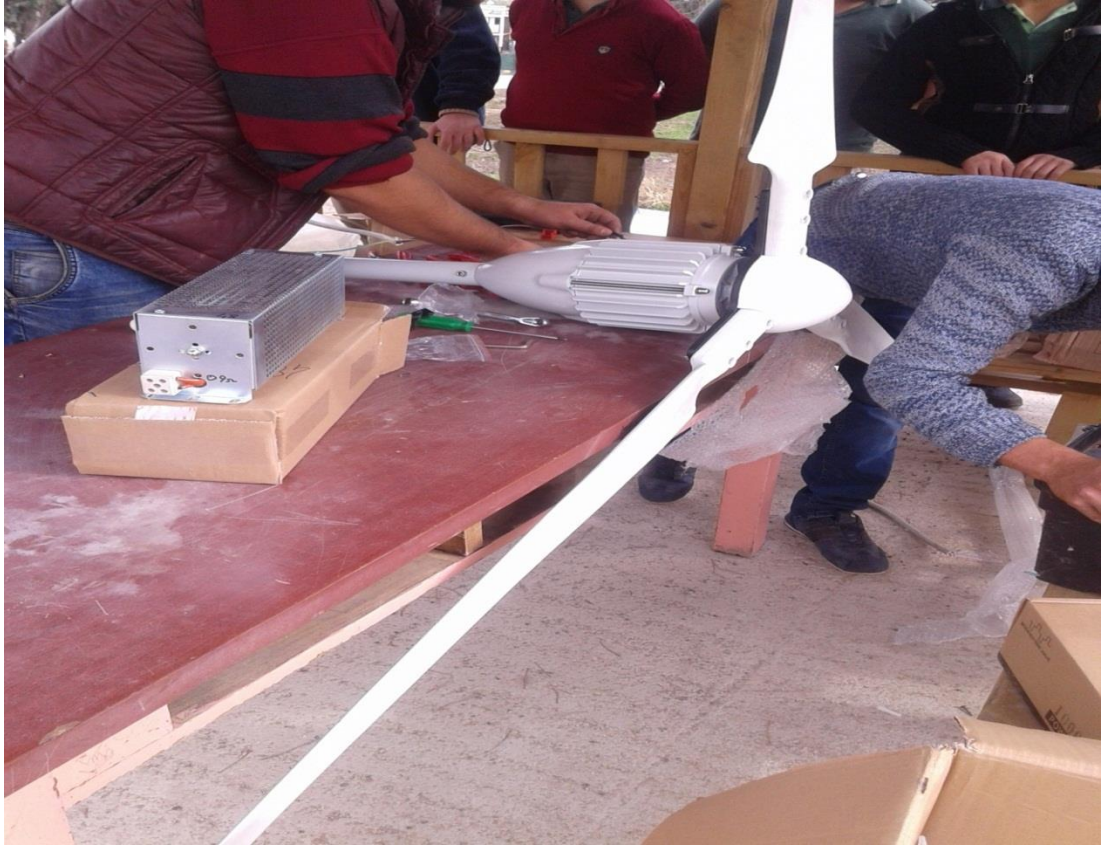
Şekil Ek A.1. Rüzgâr türbini ve kanat montaj çalışması.
