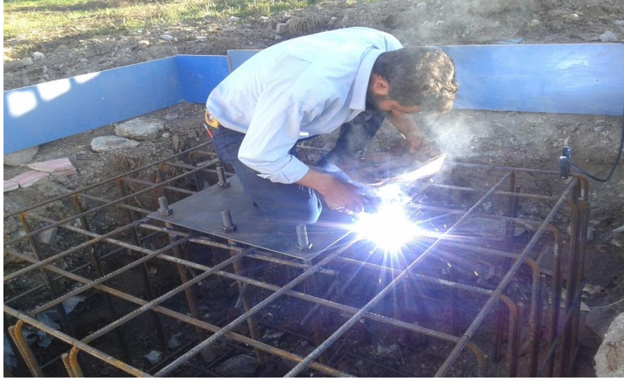
Şekil 5.1. Türbin direk montajı için yapılan çalışmalar.
