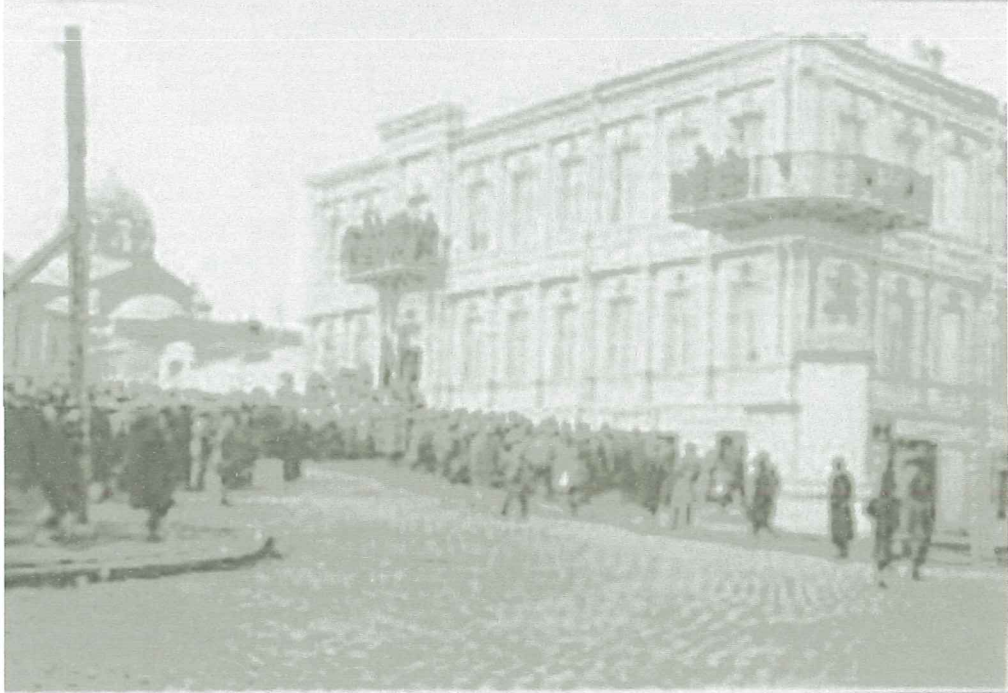
Resim 25: Eski Belediye Binası
