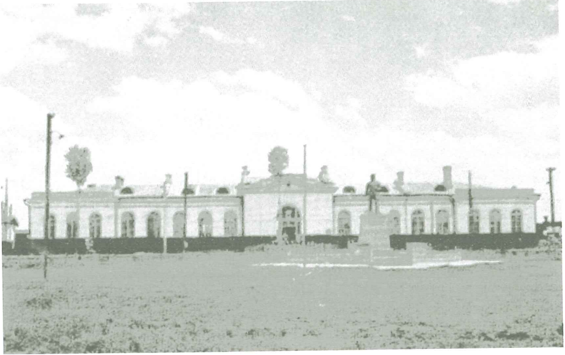
Resim 36: İstasyon Binası Eski Görünümü (Kaynak: Eski-Yeni Fotoğraflarla Kars)
