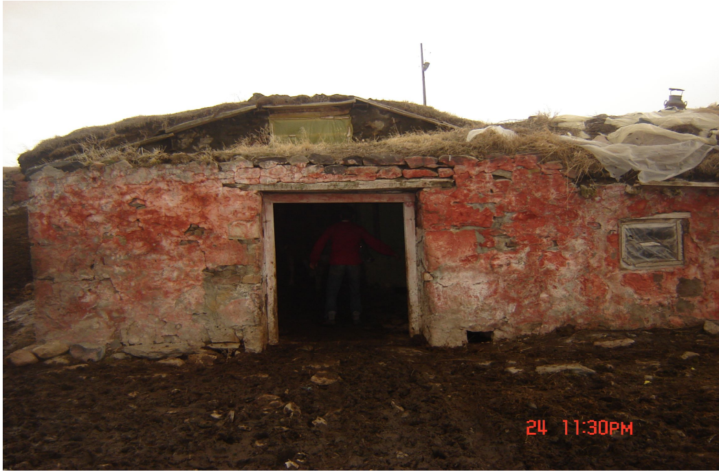
Resim 3.2 Toprak damlı ahır dış görünüş
