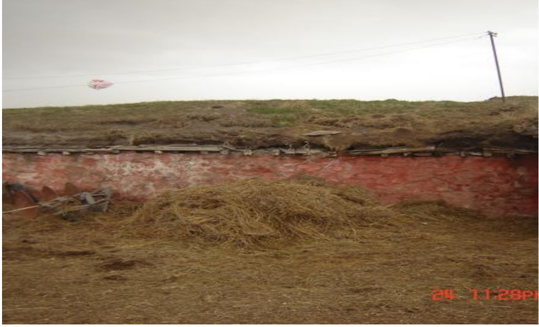
Resim 3.1 Toprak damlı ahır dış görünüş
