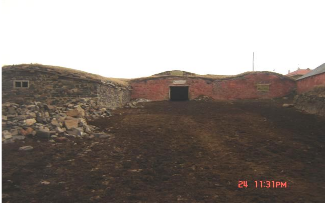
Resim 3.3 Toprak damlı ahır dış görünüş
