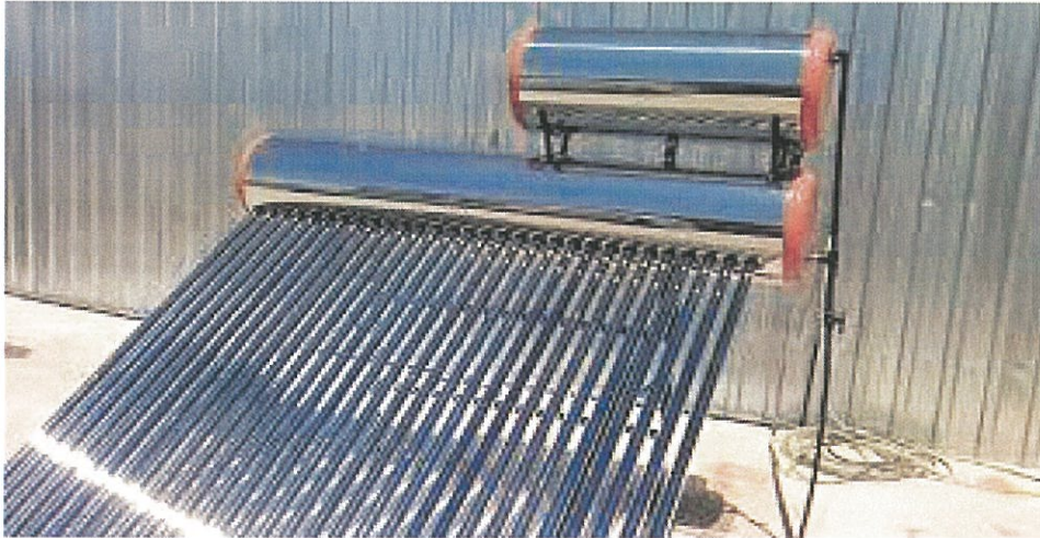
Şekil 19. Vakumlu güneş kolektörü [33].
