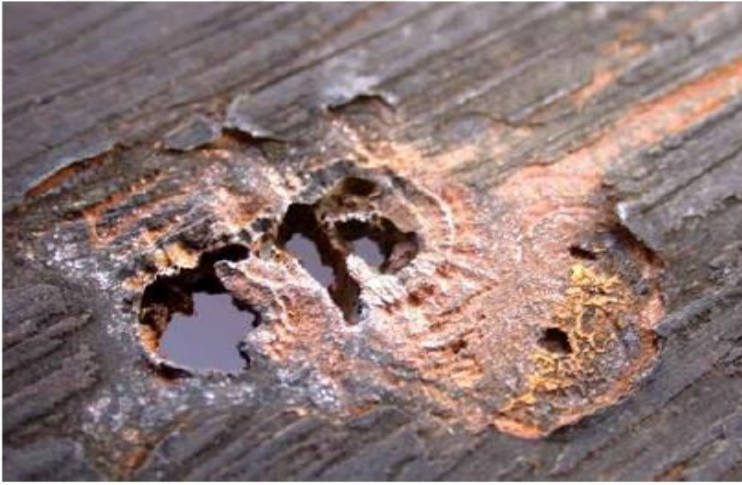
Şekil 1.8. Biyolojik korozyona uğramış su deposu (URL-7 2017)
