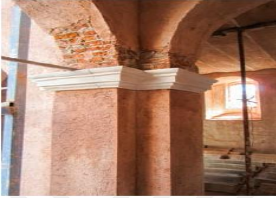
Şekil 1. 26: Hidrolik kireç bağlayıcı kullanılarak restore edilmiş tarihi bir yapı
