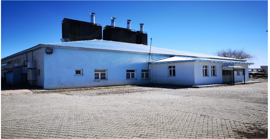
Şekil 3.3. Kafkas Üniversitesi Paşacıyırı Yerleşkesi Isı Merkezi'nin dış görünüşü
