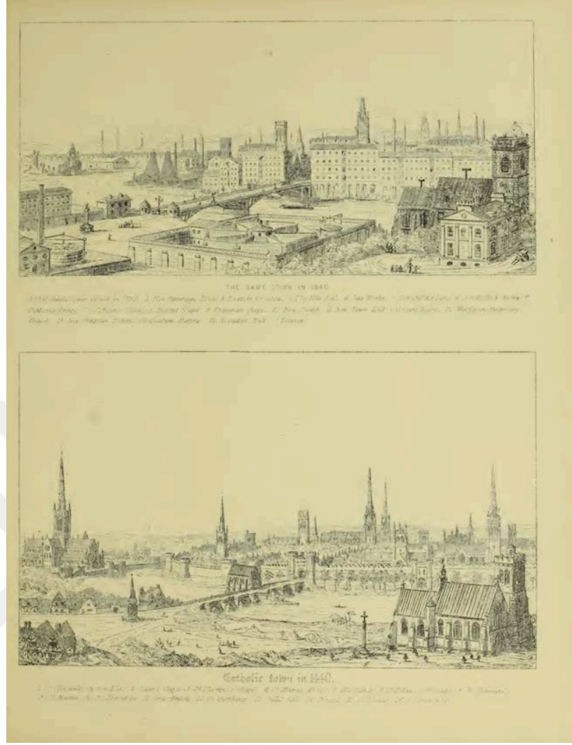
Şekil 2.9: Edinburg'un 1440'lar ve 1840'lardaki görünümünün karşılaştırılması (J.Grant), (Pugin, Contrasts: or a parallel between the noble edifices of the middle ages, and corresponding buildings of the present day; shewing the present decay of taste , 1898).
