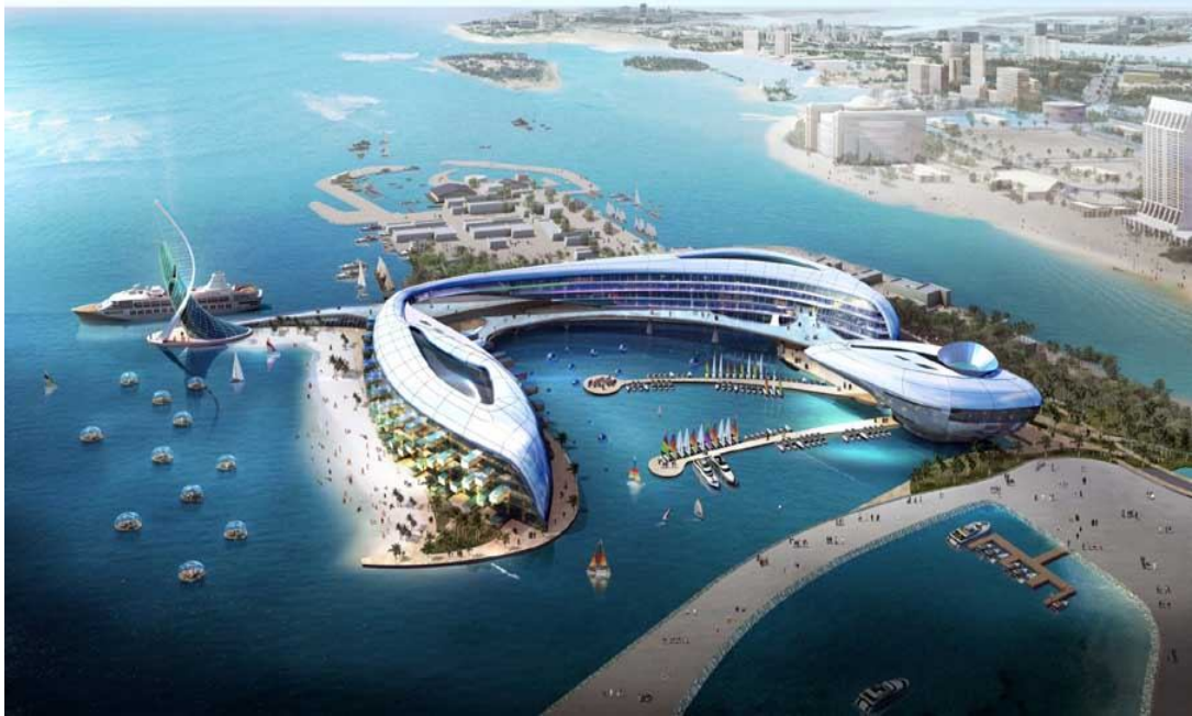
Şekil 17. Abu Dhabi Marina Hotel -Ka3 Design Group Tasarım Projesi-Genel Görünüm
