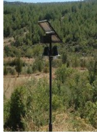
Şekil 3.2 Cephane Müfrezesi İç Yolları ve Çevre Aydınlatmasında Kullanılabilecek Güneş Pilleri
