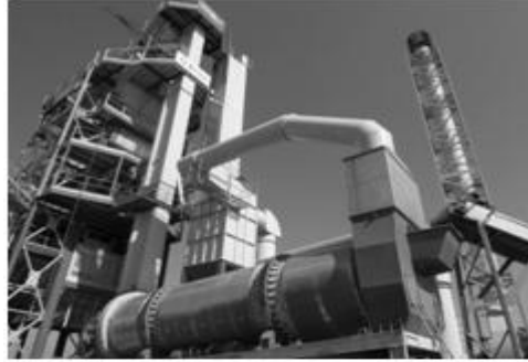
Şekil 5.2. Asfalt Plenti Görünüm
