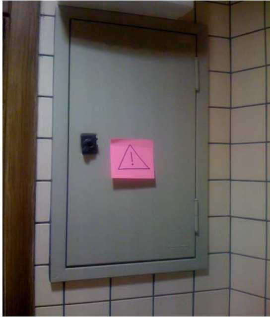
Őekil. 5.6. Sigorta Dğmelerinin Bulunduđu Blme İř Kazalarını nlemek Adına Yerleřtirilen Bir İkaz İřareti.
