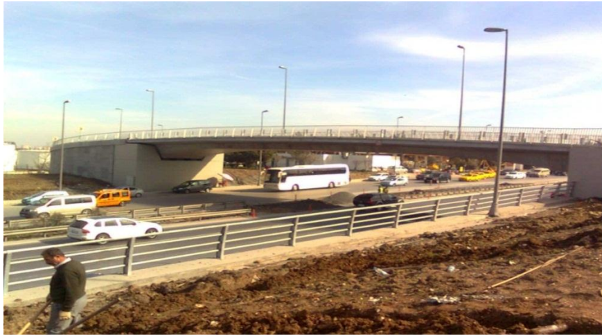
Şekil 6.4: N Yolu Köprüsünün Bitmiş Hali
