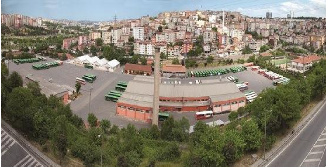
Şekil 5.1. Garajlar ve İETT araçlarının bakım onarımı
