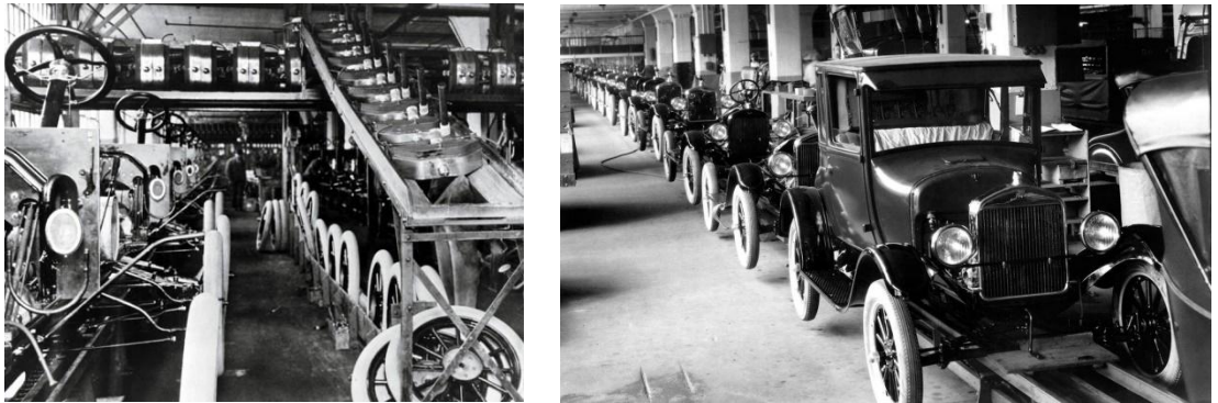
Şekil 2.1. "Model T" araba modelinin montaj hattı (Ford, 2016) , (Palmer, 2014)
