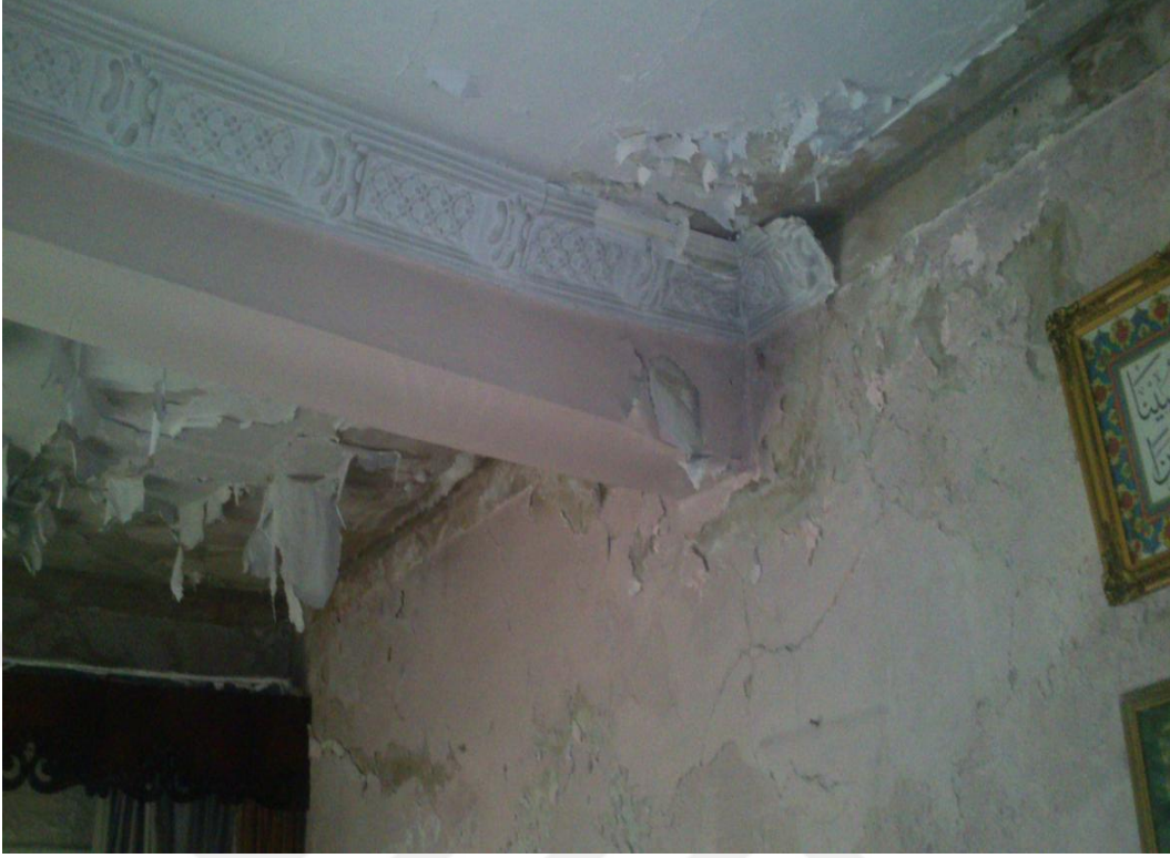
Şekil 3.3. Binanın betonarme tavan görünümü
