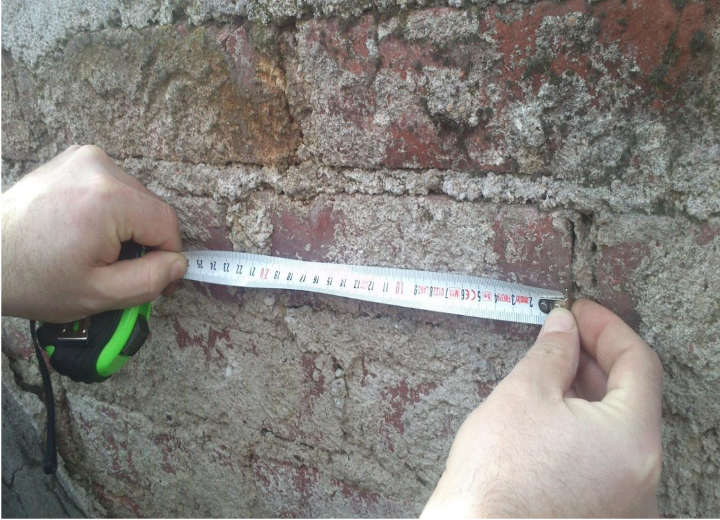
Şekil 3.4. Binada taşıyıcı duvar tespiti
