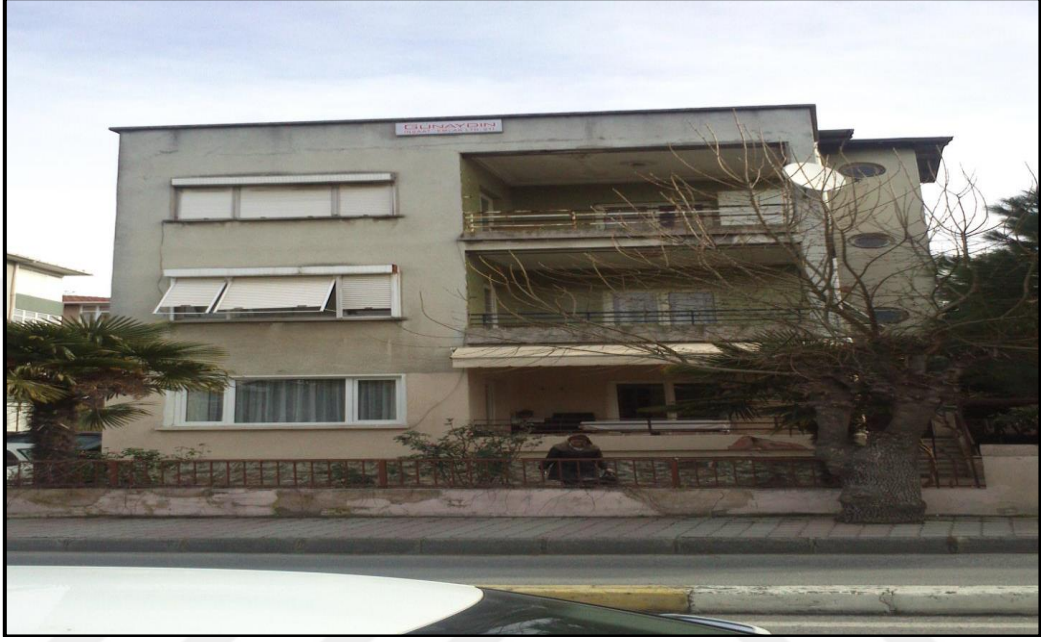
Şekil 3.1. İncelenen binanın ön görünüşü
