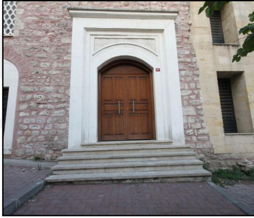
Ağa Hamamı Cephe Fotoğrafi Detay
