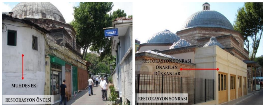
Şekil A.11. Yapı çevresinde bulunan dükkânları restorasyon aşaması (
