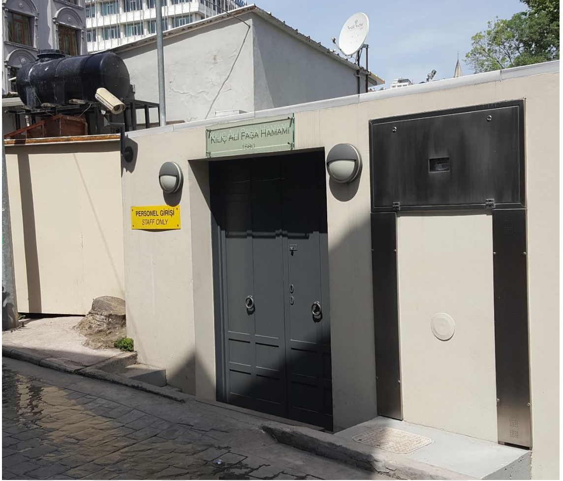
Şekil A.14. Restorasyon sürecinde yeni eklenen personel alanının girişi.
