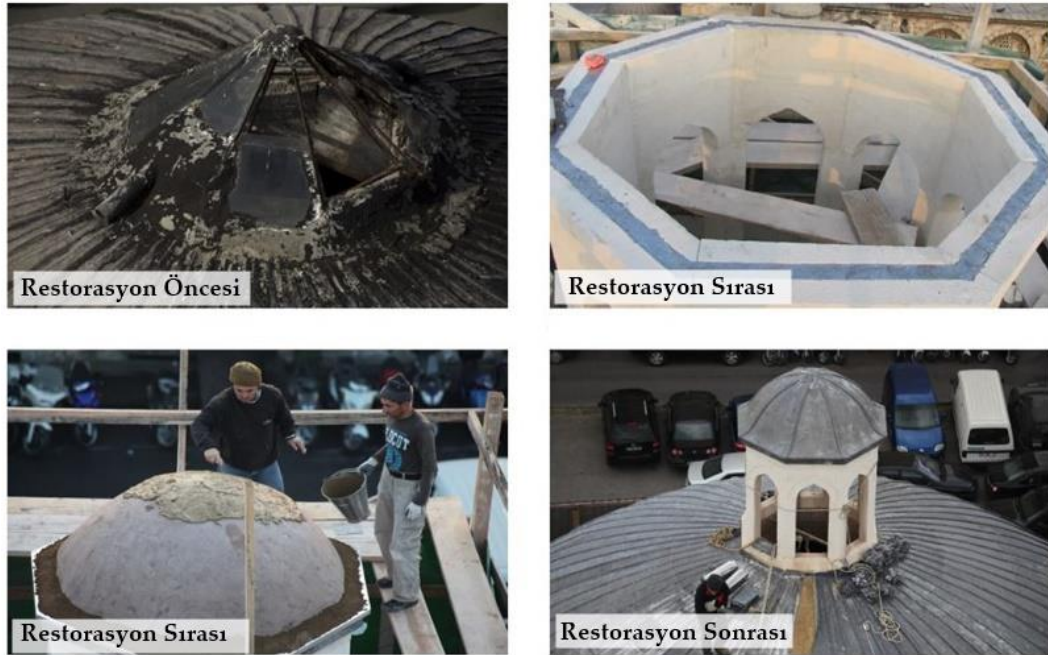
Şekil A.9. Restorasyonda eklenen Fener detayı ( http://www.cba-ist.com geliştirilmiştir)
