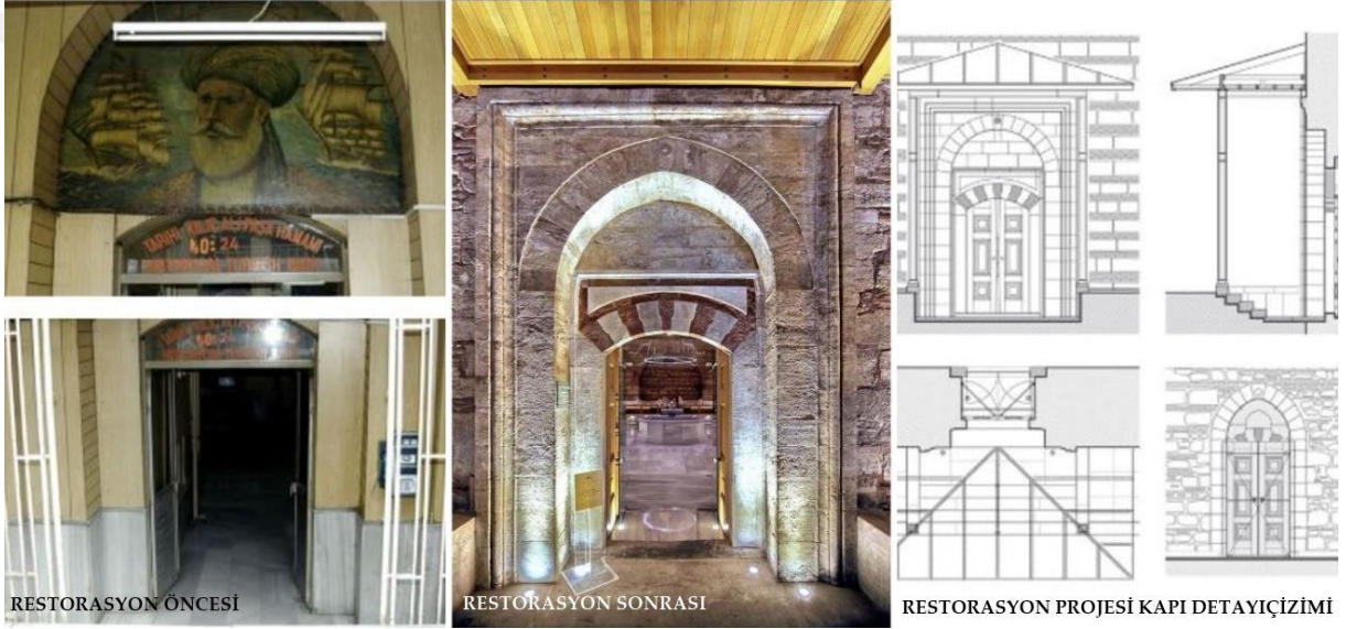
Şekil A.7. Giriş Kapısı Restorasyon Öncesi, Sonrası ve Çizimi. ( http://www.cba-ist.com )
