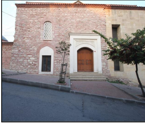
Ağa Hamamı Cephe Fotoğrafi
