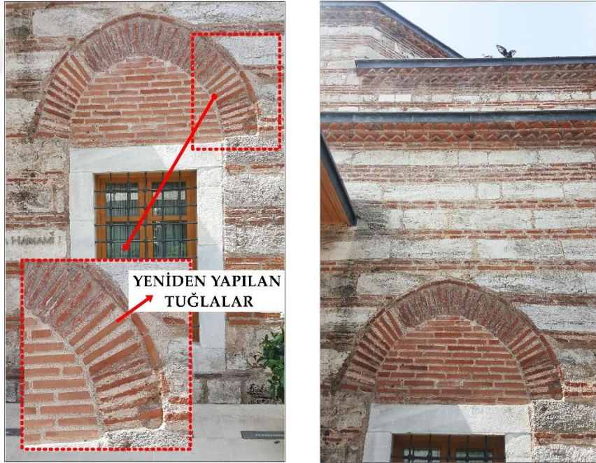
Şekil A.6. Dış Cephe Restorasyonu Sırasında Eklenen Taşlar. (Elif Çelik)
