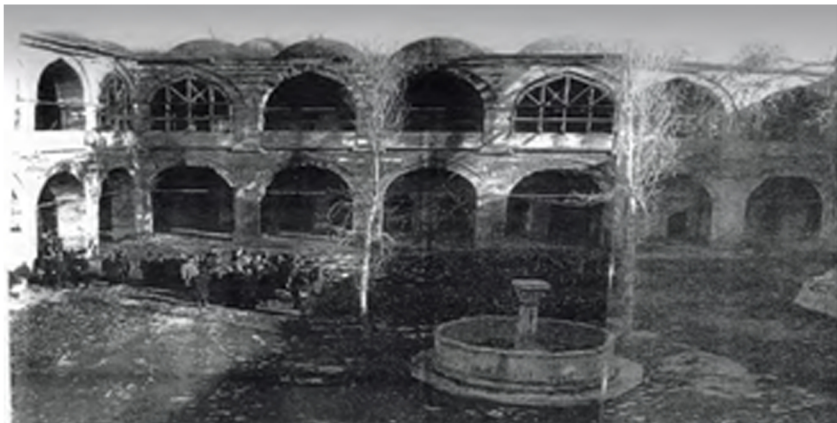
Şekil 7.15.Rüstempaşa Kervansarayı onarım öncesi (Vakıflar Genel Müd. Arş.)
