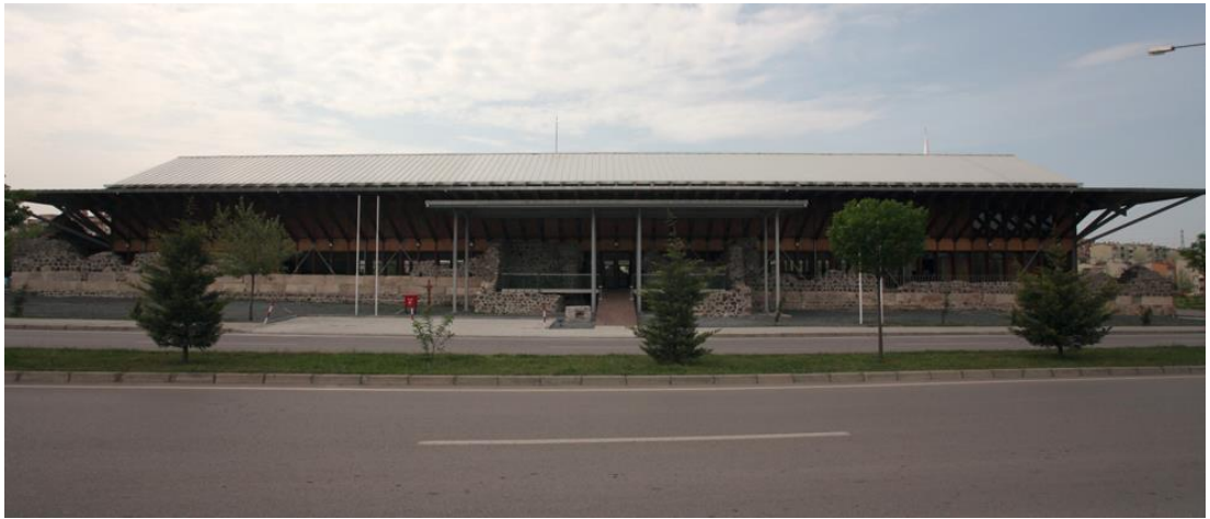
Şekil 6.27. Kazıklı Kervansarayı Ön Cephe (vitracagdasmmimarlikdizisi.com/projeler)
