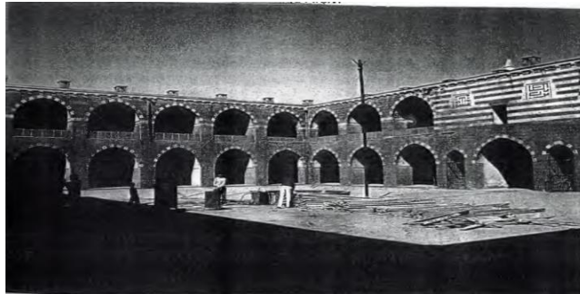
Şekil 7.26. Diyarbakır Deliller Hanı Restorasyon Çalışması.
