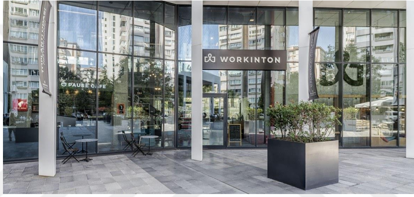
Şekil 4.1.20. Workinton Kozyatağı And şubesi iç avluya bakan dış cephe görüntüsü
