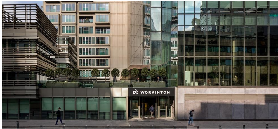
Şekil 4.1.3. Workinton Levent 199 şubesi dış cephe görüntüsü
