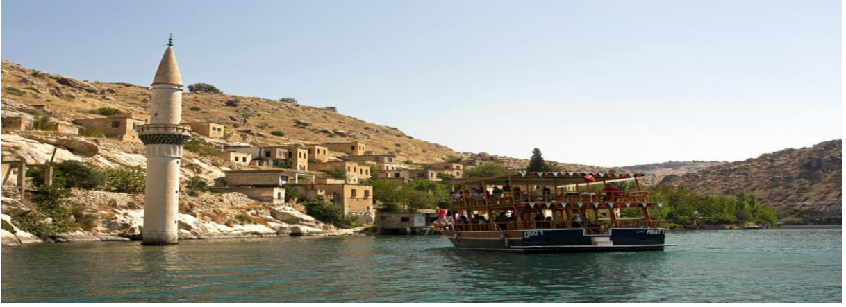
Şekil 3.19 Birecik barajının yıkılmasıyla eski Halfeti bölgesi (Vahap Selim Ekşi, 2018).
