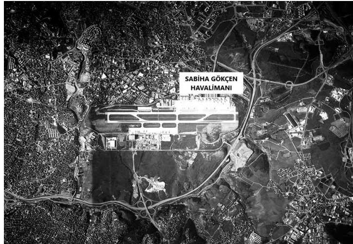
Şekil 3.18. Sabiha Gökçen Havalimanı ( http://www.sgairport.com/foto-galeri )
