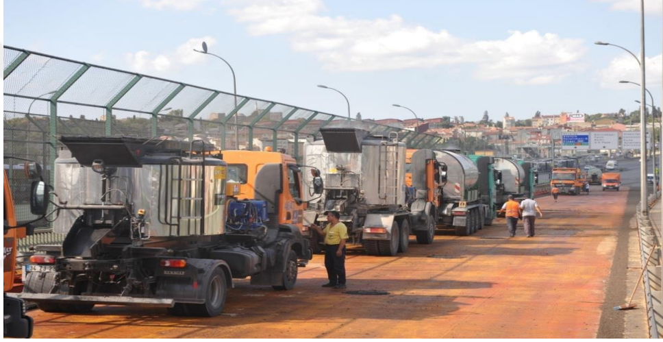
Şekil 4.9. Özel ısıtıcılı MA taşıyıcısı (cooker)
