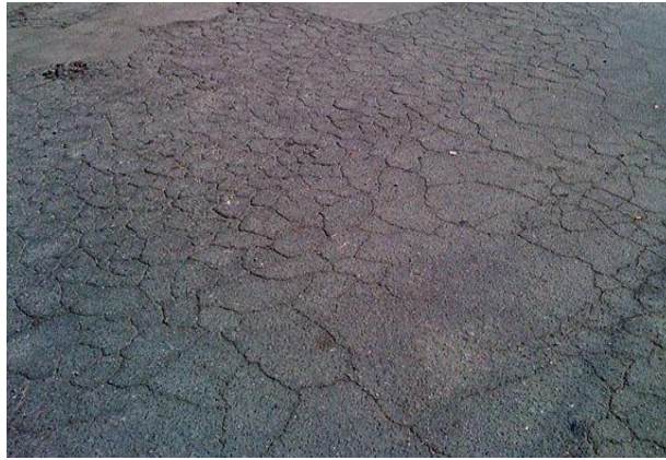
Şekil 3.12. Timsah sırtı çatlaęı görüntüsü
