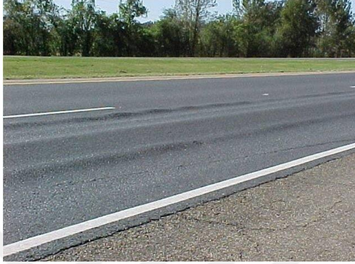
Şekil 3.6. Tekerlek izi oluşumu (Cornell, 1995)
