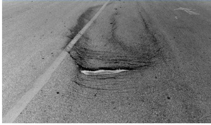
Şekil 3.16. Kayma çatlağı görüntüsü
