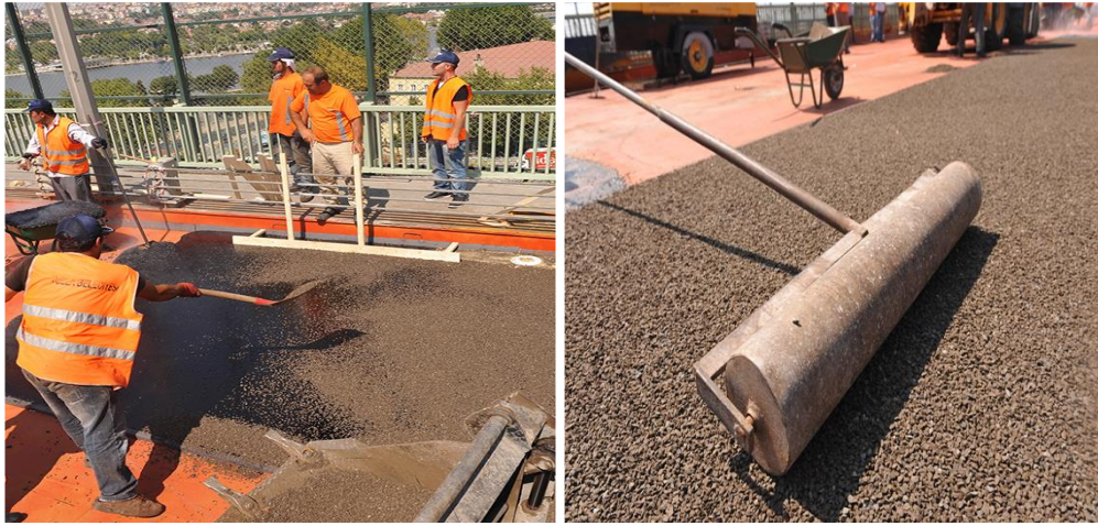
Şekil 4.10. Cipping uygulaması ve sıkıştırılması
