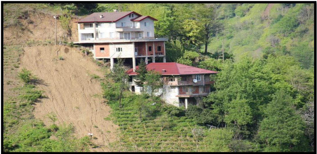
Şekil 3.10. Yıkılacak tehlikede tehlikeli yapılar (Mynet, 2018).
