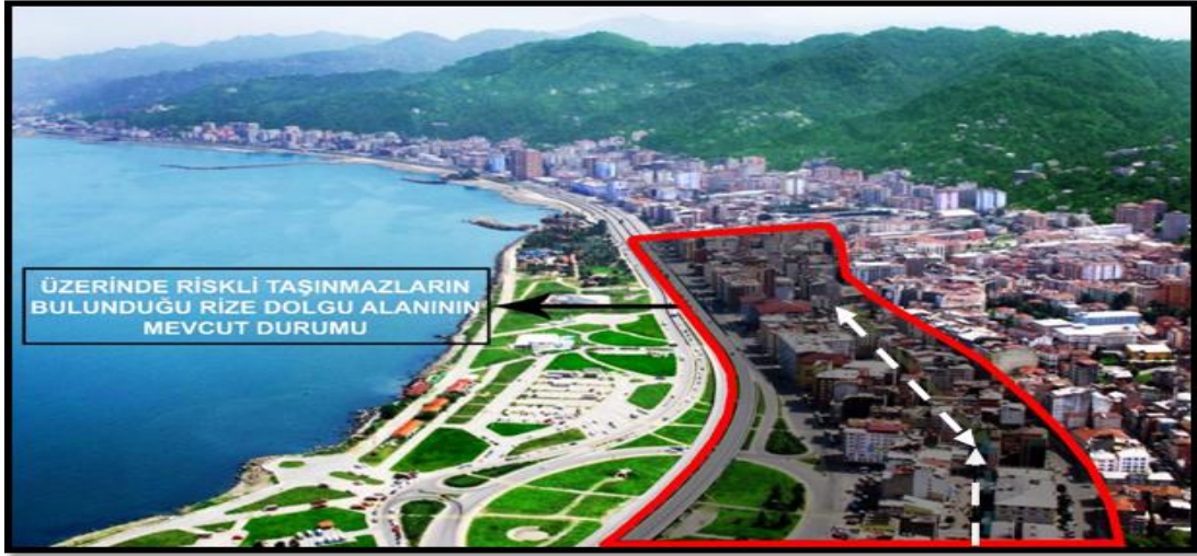
Şekil 3.7. Riskli yapıların bulunduğu Rize merkez dolgu sahası (Kişisel Arşiv, 2019).
