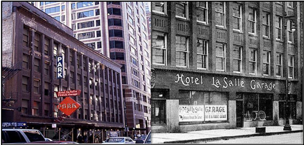
Şekil 3.1. Hotel müşterileri için inşa edilen katlı otopark (Laskow, 2016)
