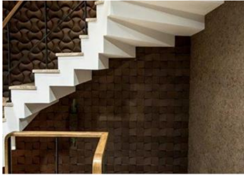
Şekil 4.7 Merdiven kovanında hissedilebilir kabartma yüzey (muratto.ru Web Sitesi)
