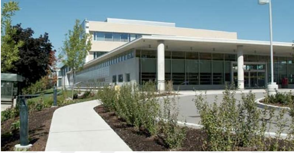
Şekil 4.8 Kanada Ulusal Enstitüsü'nde görme engellileri yönlendirme amacı ile koku ögesinin kullanımı (Archinect Firm, 2016)
