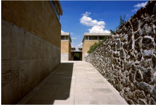
Şekil 4.11 Meksika Mexico city kör ve görme engelliler merkezi görme engellileri yönlendirme amacı ile farklı duvar dokusu kullanımı (plataformaarquitectura.cl Web Sitesi)
