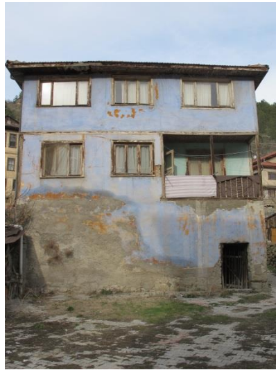
Şekil 2. 43: Yukarı Hamam konut kısmı güneybatı cehpesi
