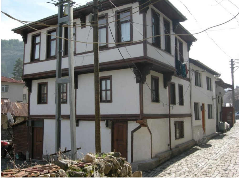
Şekil 3. 31: Geleneksel konutta köşe pahu
