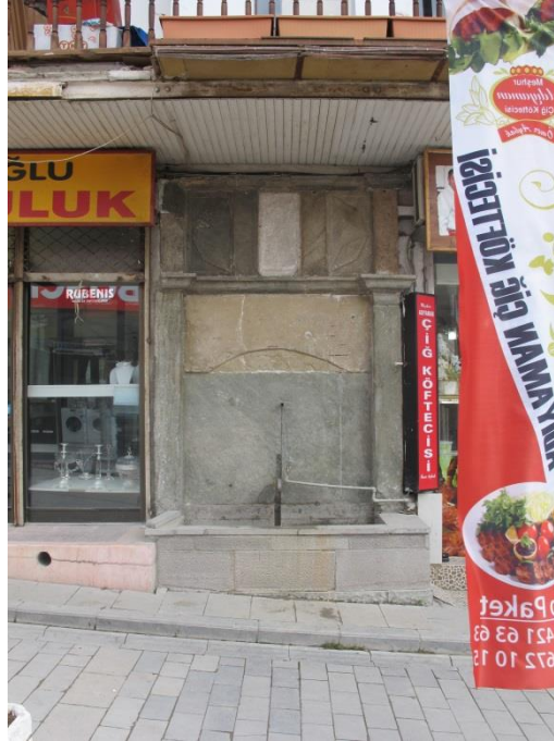
Şekil 3. 30: Arastada bulunan tescilli çeşme
