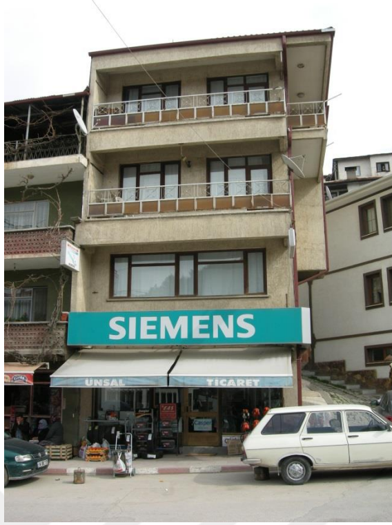
Şekil 3. 6: Zemin + 3 katlı betonarme yapı
