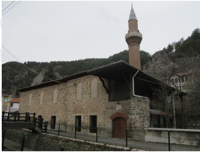
Şekil 2. 26: Kanuni Sultan Süleyman Camii doğu cephesi ve son cemaat yeri
