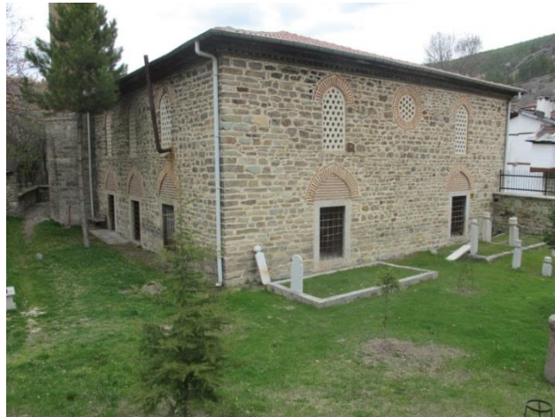
Şekil 2. 29: Kanuni Sultan Süleyman Camii batı cephesi ve kible cephesi
