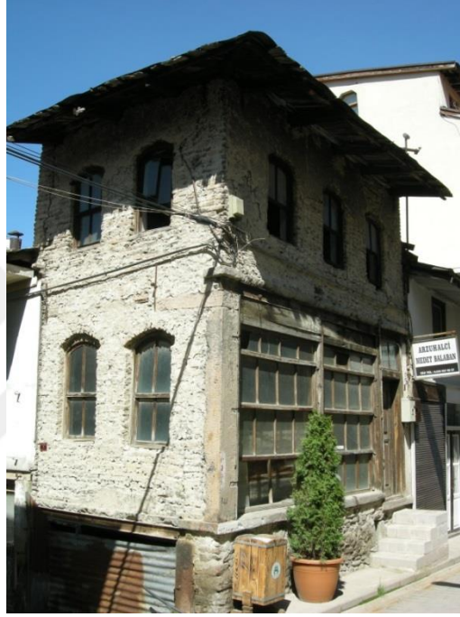
Şekil 3. 16: Tarihi arastadaki yapıların yığma yapım sistemi
