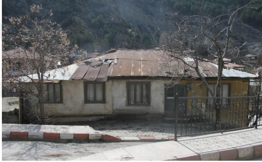
Şekil 2. 42: Hamamcı evi kuzeydoğu cehpesi
