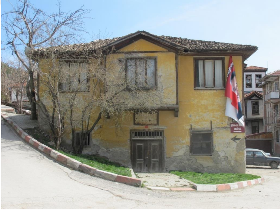
Şekil 2. 39: Yukarı Hamam kuzey /giriş cephesi
